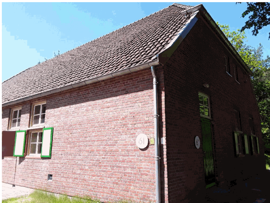
40B1861, buitenzijde gebouw
