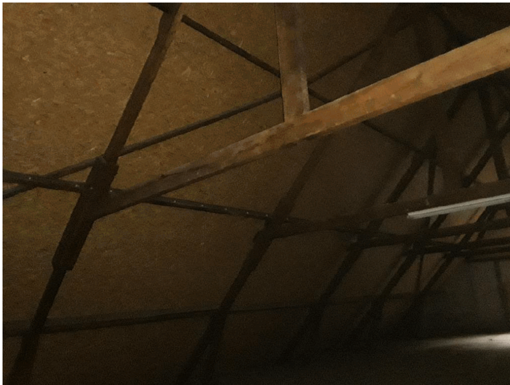
40B1861, dak en dakbeschot reeds gerenoveerd/gesaneerd
