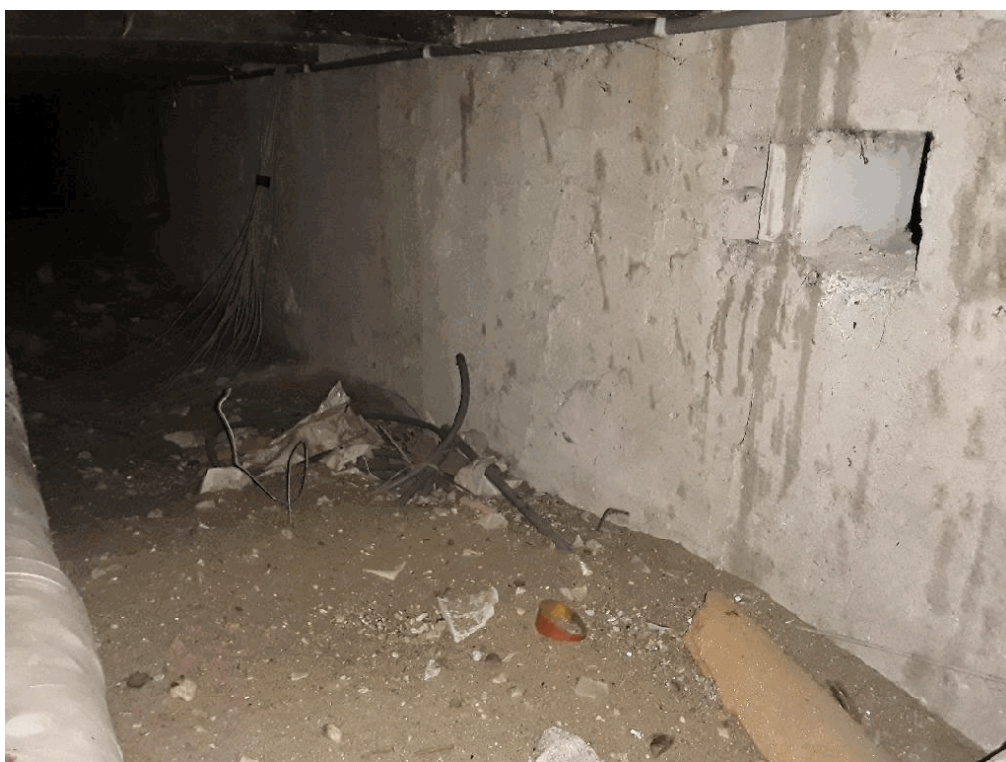
40B1861, kruipruimte geen bijzonderheden (bitumen en leidingisolatie niet asbestverdacht, zie deskresearch)
