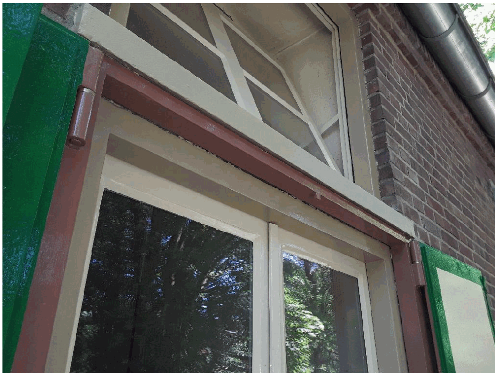
40B1816, gevelkozijnen recent beglazing vervangen en geschilderd (zie deskresearch)
