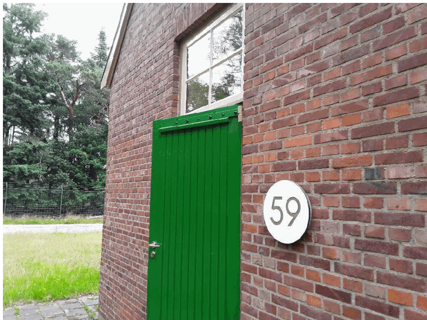
40B1859, buitenzijde gebouw
