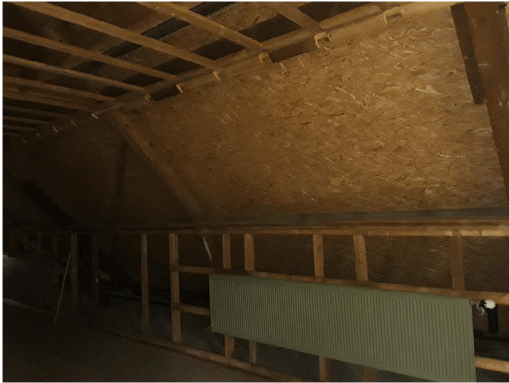
40B1859, dak en dakbeschof reeds gerenoveerd/gesaneerd
