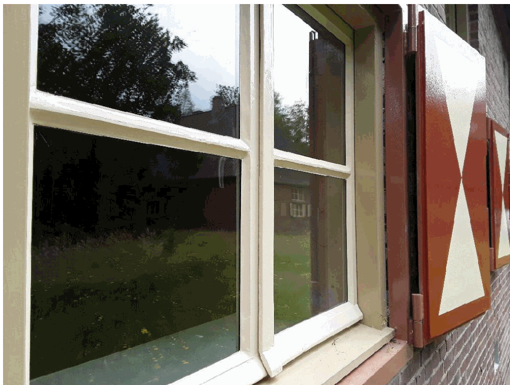
40B1859, gevelkozijnen recent beglazing vervangen en geschilderd (zie deskresearch)
