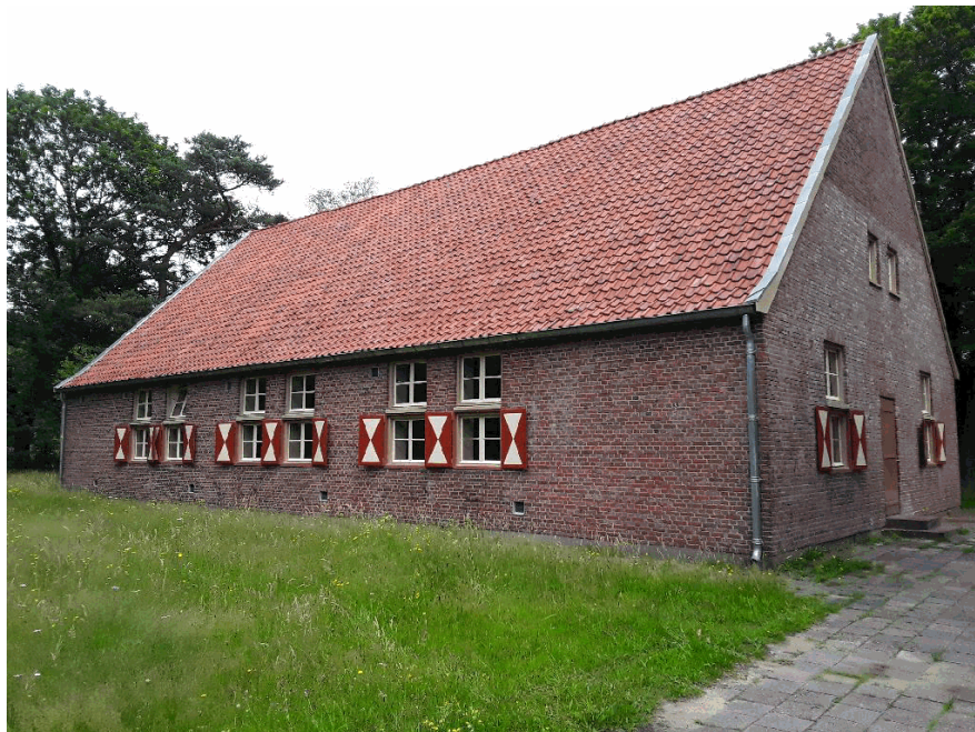
40B1859, buitenzijde gebouw
