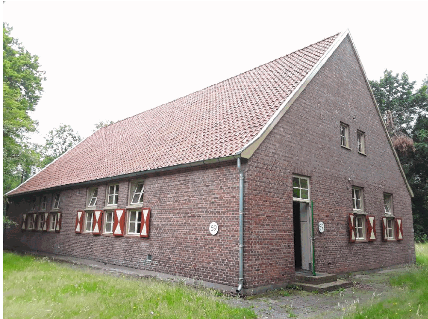
40B1859, buitenzijde gebouw
