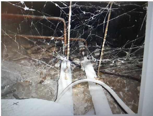
FB05: De leidingisolatie is conform de oude rapportage niet asbesthoudend.
