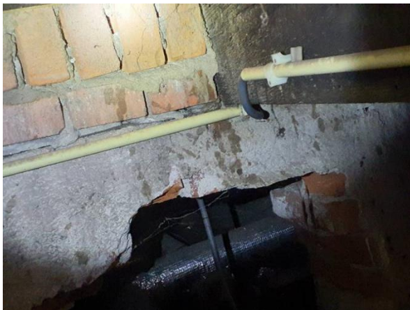
FB09: De bitumen tussen de houten balken en het metselwerk is conform de oude rapportage niet asbesthoudend.
