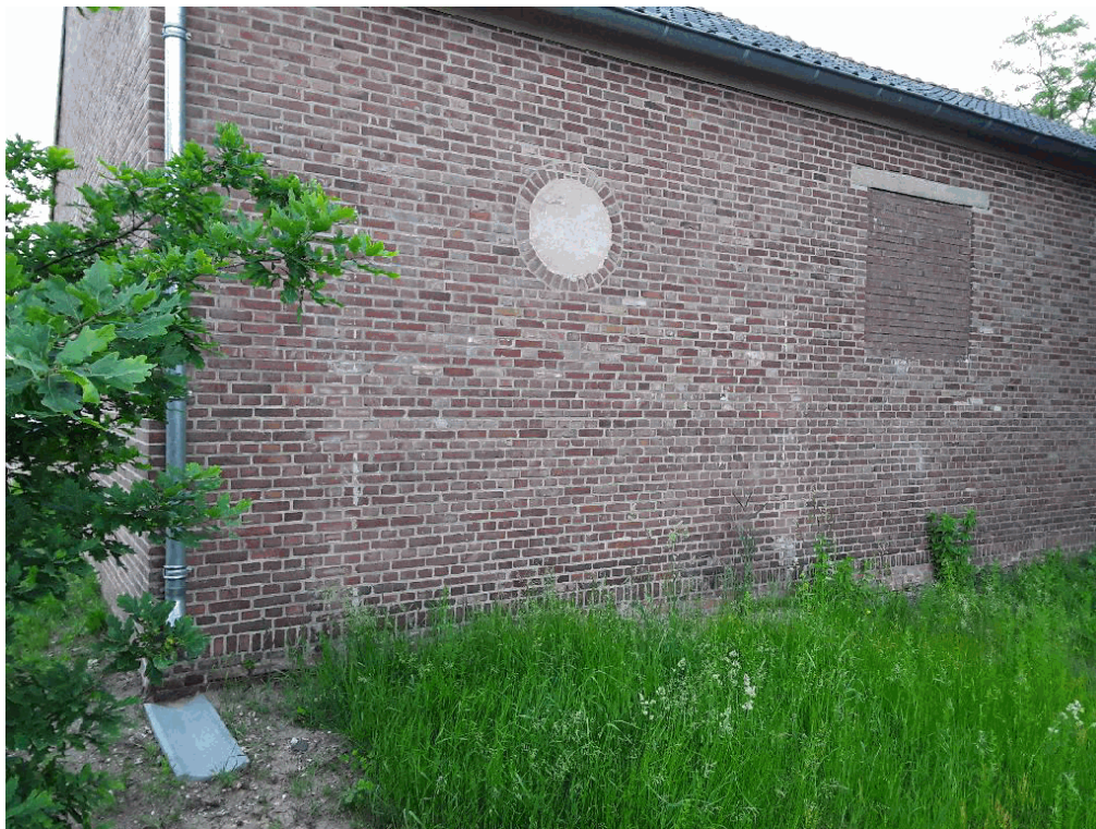
40B1847, aanbouwen linker- en achterzijde met golfplaten: reeds verwijderd/gesaneerd
