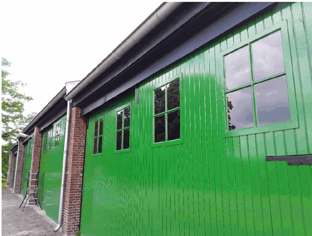
40B1847, gevelkozijnen: recent beglazing vervangen/geschilderd (zie deskreseach)
