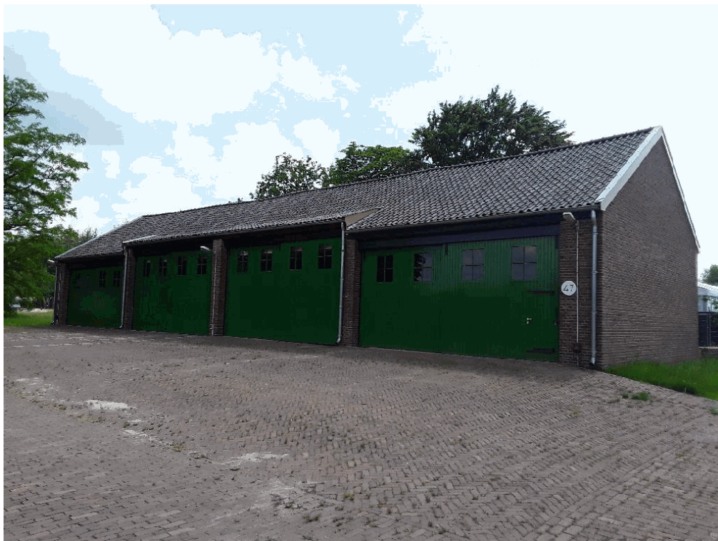
40B1847, buitenzijde gebouw
