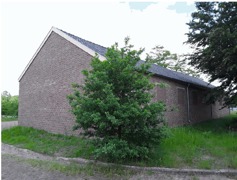
40B1847, buitenzijde gebouw
