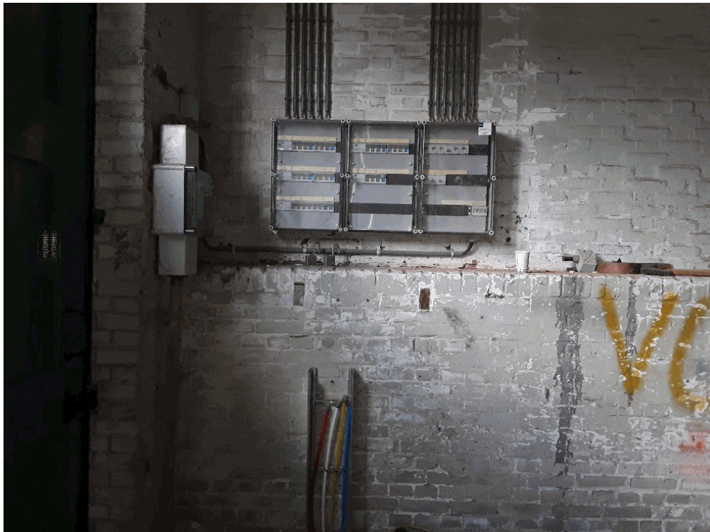
40B1847, elektrische installatie: niet asbestverdacht
