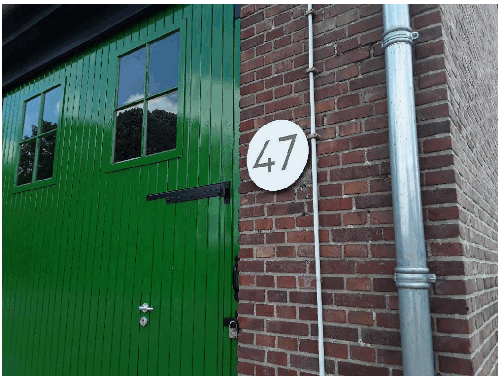
40B1847, buitenzijde gebouw
