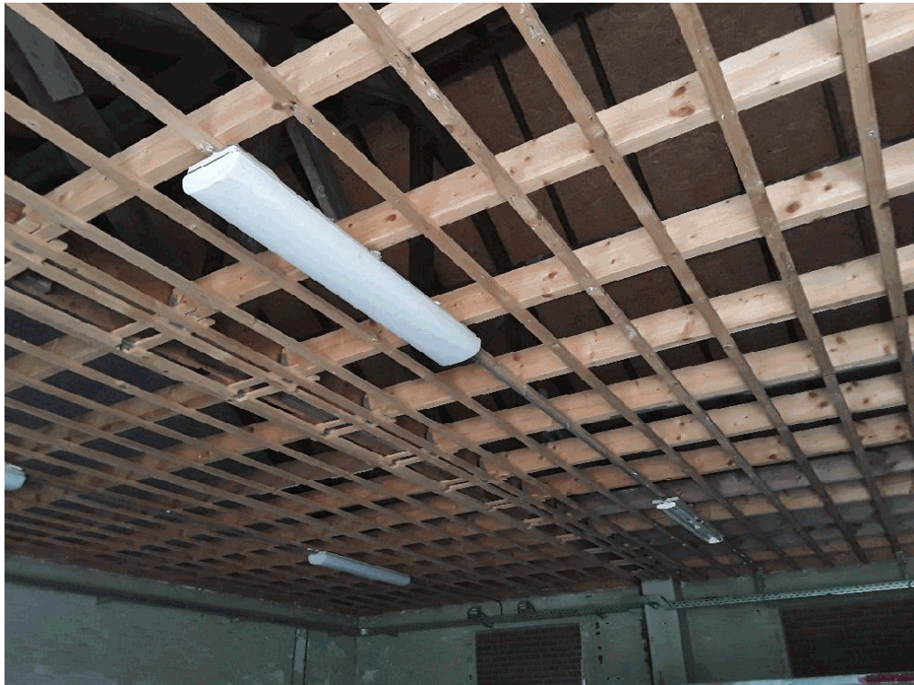
40B1847, geen asbestverdachte materialen aangetroffen
