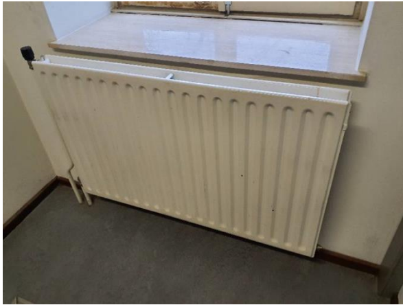
FB07: De radiatoren zijn niet asbestverdacht.
