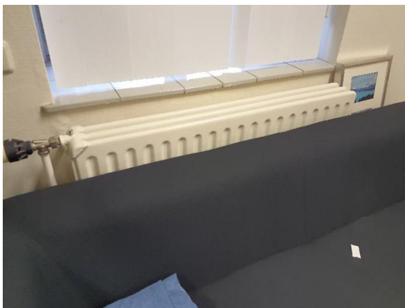
FB03: De radiatoren zijn niet asbestverdacht.
