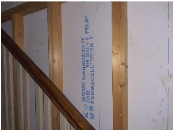
FB02: De brandvertragende beplating is niet asbestverdacht.
