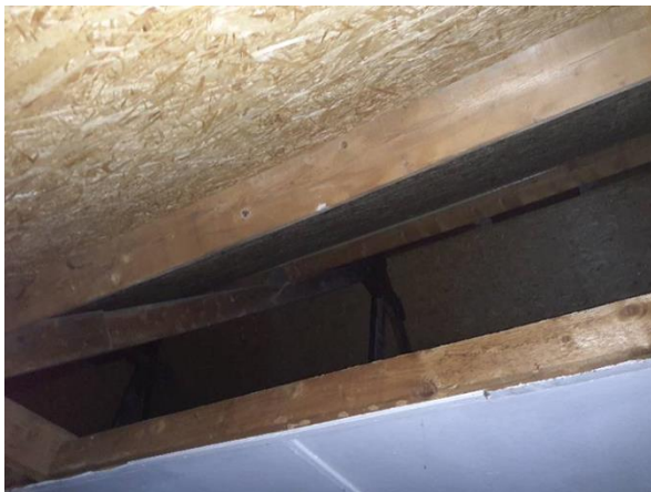
FB03: Het dakbeschot is niet asbestverdacht.
