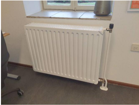
FB01: De radiatoren zijn niet asbestverdacht.
