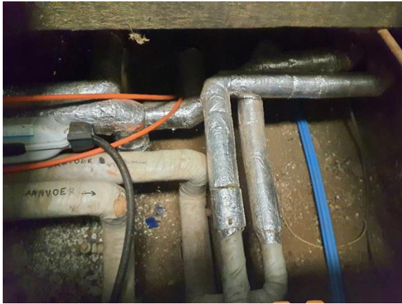
FB07: Het zichtbare leidingwerk is niet asbestverdacht.
