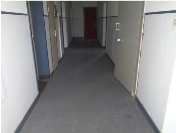
FB10: Onder de zichtbare vloerafwerkingen is geen inspectie mogelijk.
