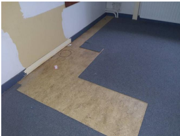
FB11: Onder de zichtbare vloerafwerkingen is geen inspectie mogelijk.
