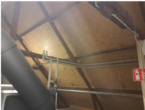
FB05: Het dakbeschot is niet asbestverdacht.
