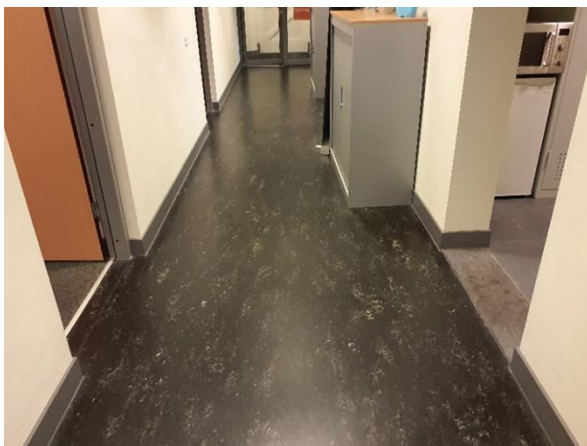
FB06: Onder de zichtbare vloerafwerkingen is geen inspectie mogelijk.
