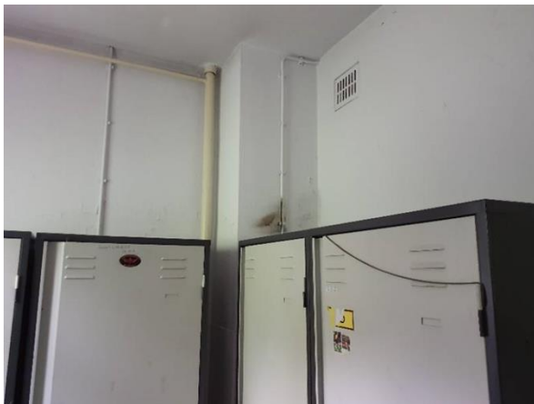
FB03: In de gemetselde kanalen is geen inspectie mogelijk.
