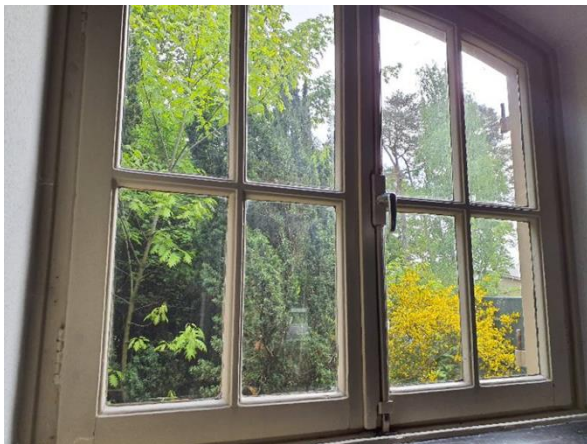
FB02: De beglazingskit en stopverf in de buitengevel is conform de oude rapportage niet asbesthoudend.
