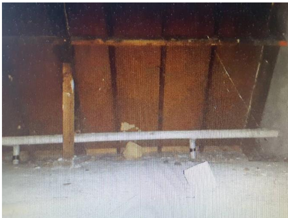
FB08: De leidingisolatie is conform de oude rapportage niet asbesthoudend.
