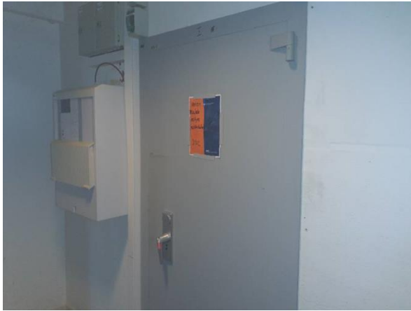
FB10: Ruimte 7A is niet toegankelijk.
