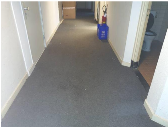
FB05: Onder de zichtbare vloerafwerkingen is geen inspectie mogelijk.
