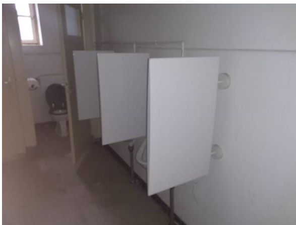
FB06: Achter het tegelwerk is geen inspectie mogelijk.
