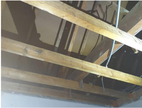
FB04: De plafondbeplating op de 1e verdieping is recentelijk gesaneerd.
