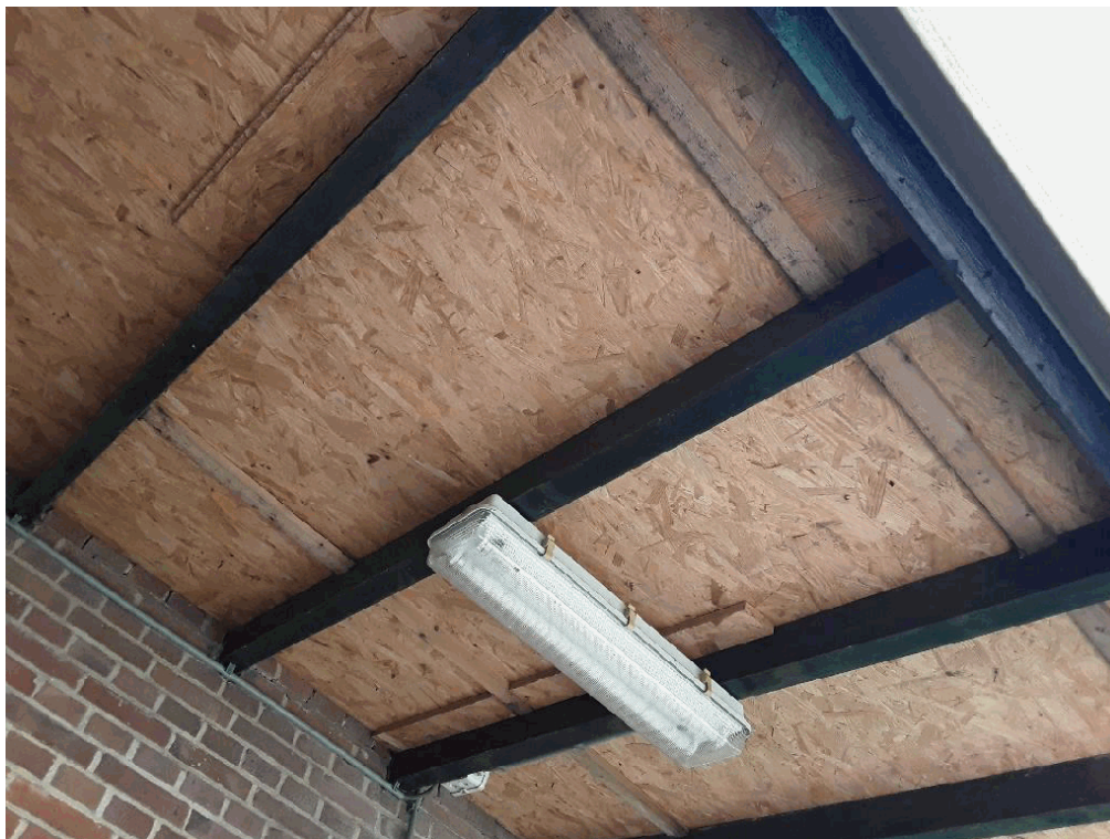
40B1825, dak en dakbeschot reeds gerenoveerd/gesaneerd
