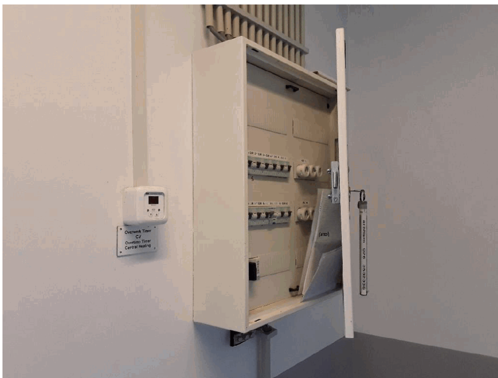
40B1825, elektrische installatie niet asbestverdacht
