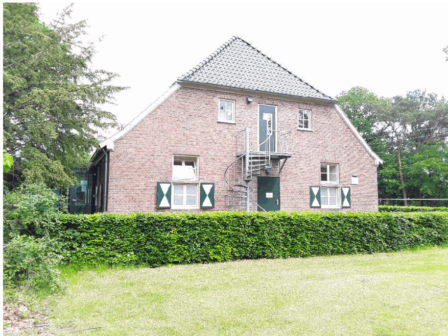
40B1825, buitenzijde gebouw
