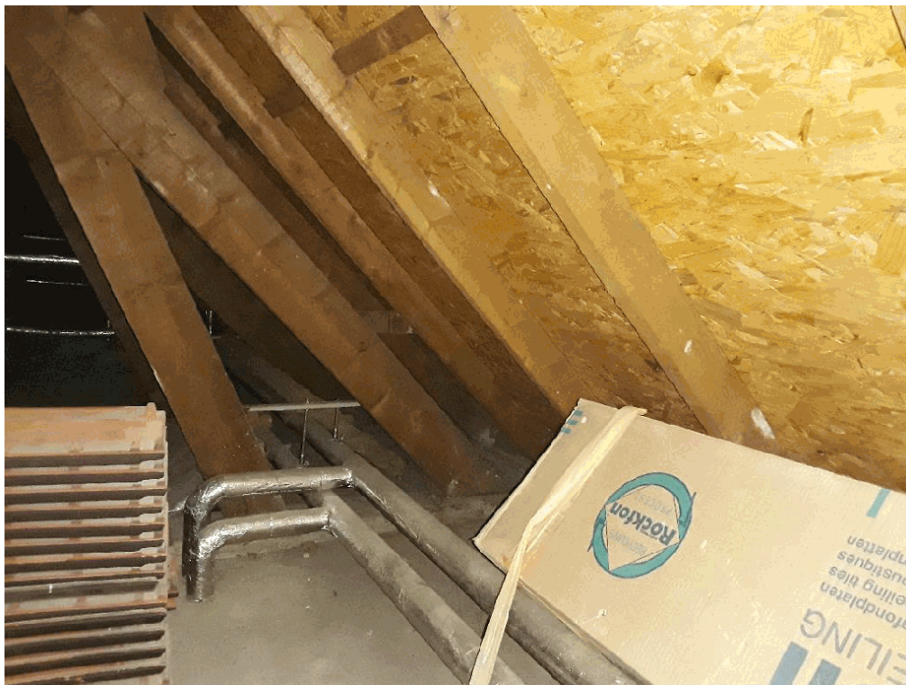
40B1825, dak en dakbeschot reeds gerenoveerd/gesaneerd
