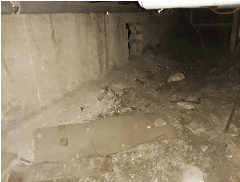
40B1825, in de kruipruimte geen asbestverdachte materialen aangetroffen
