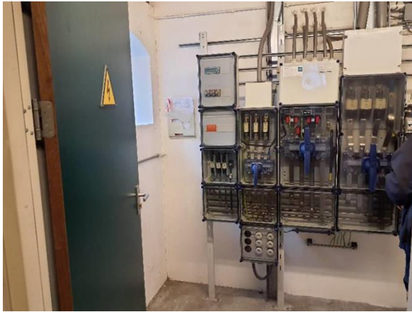
FB10: De schakelkasten zijn niet asbestverdacht.
