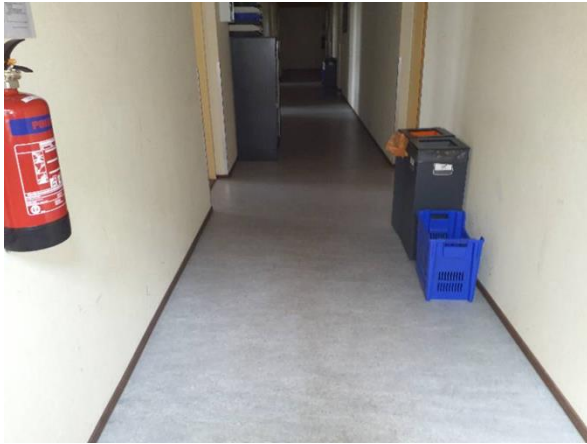
FB01: Onder de zichtbare vloerafwerkingen is geen inspectie mogelijk.
