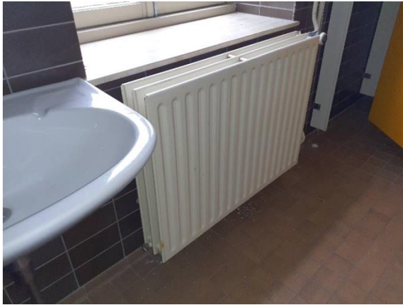
FB04: De radiatoren zijn niet asbestverdacht.
