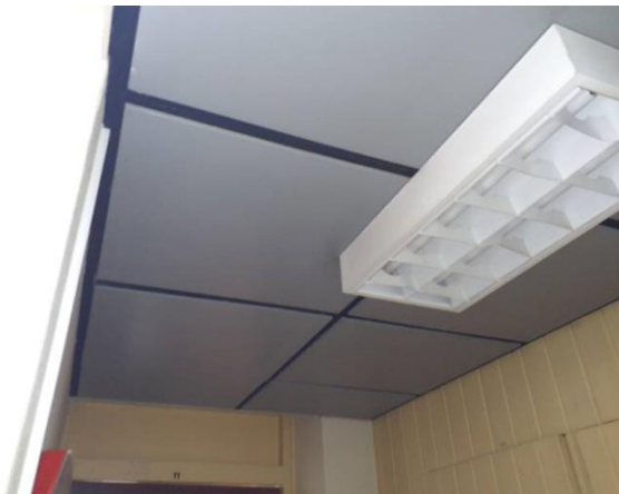
FB06: Boven vaste plafonds is geen inspectie mogelijk.
