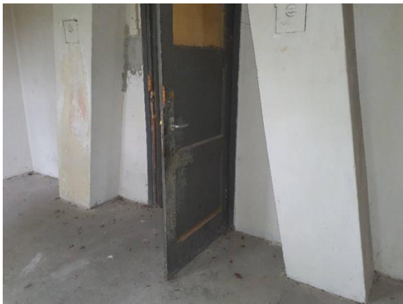
FB02: In de gemetselde kanalen is geen inspectie mogelijk.
