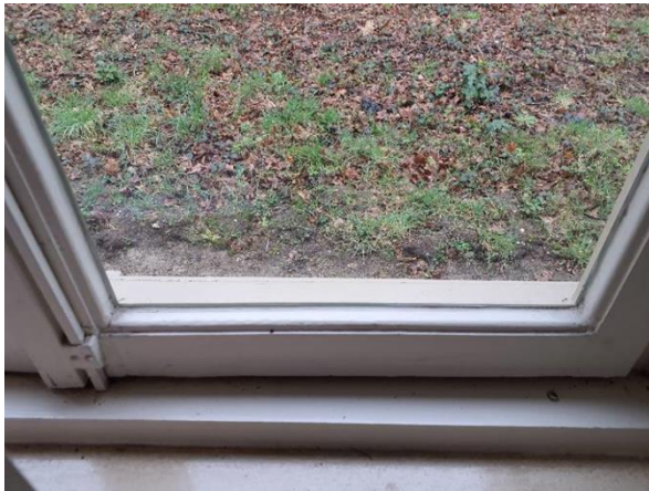
FB08: De stopverf en beglazingskit in de buitengevel, is conform de oude rapportage niet asbesthoudend.
