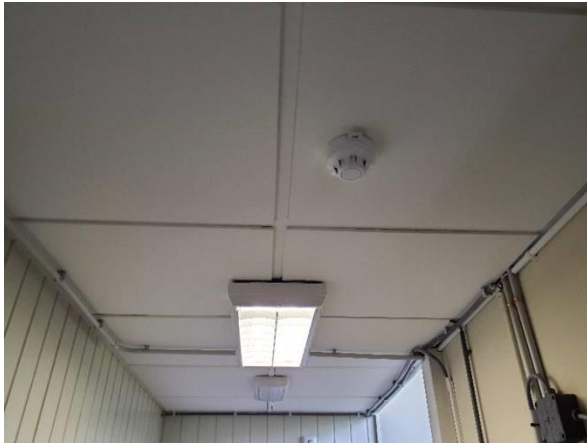
FB07: Boven vaste plafonds is geen inspectie mogelijk.
