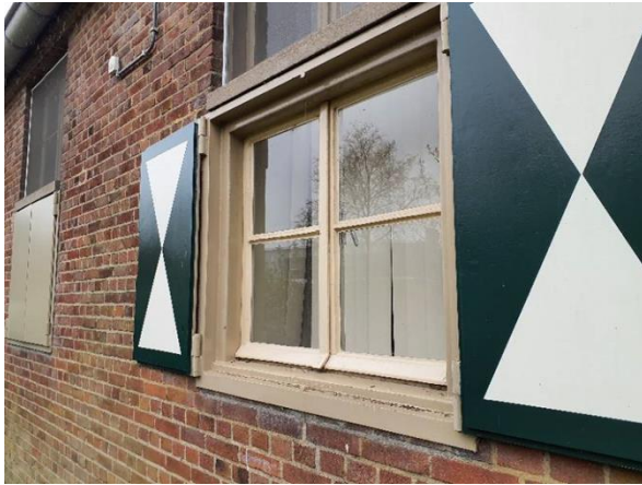
FB10: De stopverf en beglazingskit in de buitengevel is conform de oude rapportage niet asbesthoudend.
