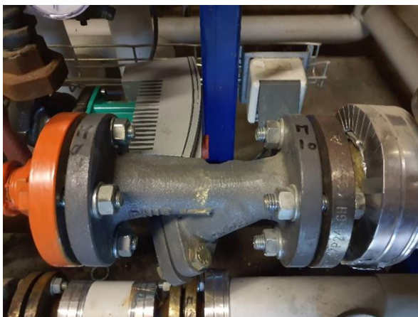
FB12: De bovenste 2 pakkingen tussen het leidingwerk in ruimte 9, zijn conform de oude rapportage niet asbesthoudend.
