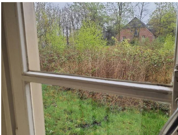
FB09: De stopverf en beglazingskit in de buitengevel is conform de oude rapportage niet asbesthoudend.
