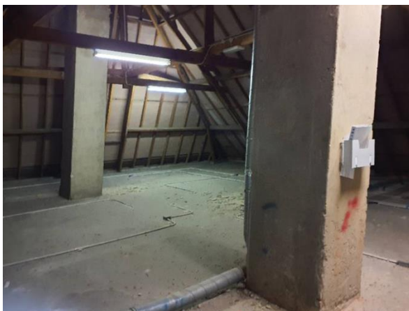
FB03: In de gemetselde kanalen is geen inspectie mogelijk.
