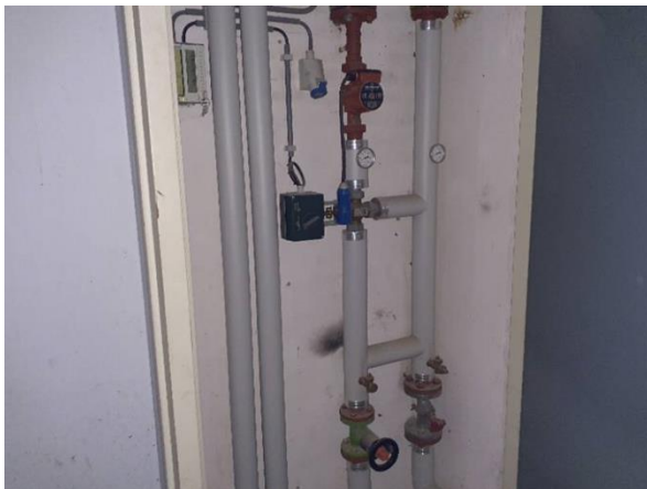
FB06: De pakkingen tussen de flenzen van het leidingwerk zijn conform de oude rapportage niet asbesthoudend.
