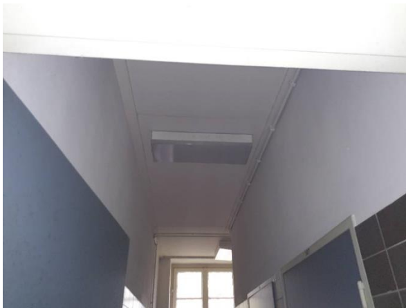
FB05: Boven vaste plafonds is geen inspectie mogelijk.
