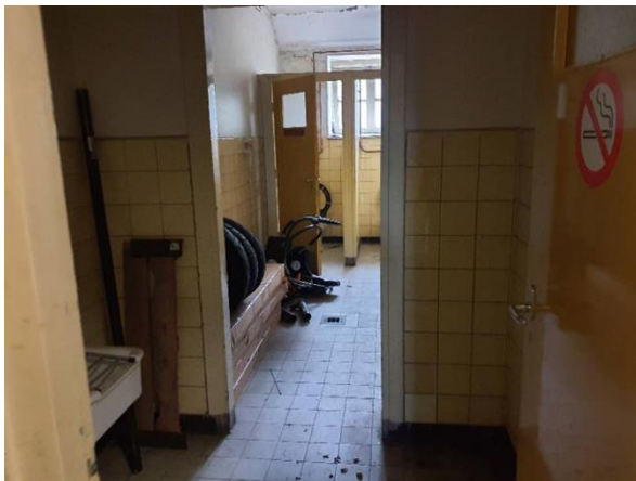
FB06: Achter het tegelwerk is geen inspectie mogelijk.
