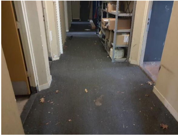
FB04: Onder de zichtbare vloerafwerkingen is geen inspectie mogelijk.
