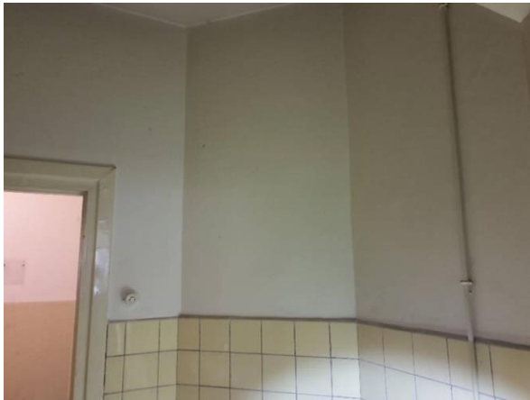
FB05: In de gemetselde kanalen is geen inspectie mogelijk.
