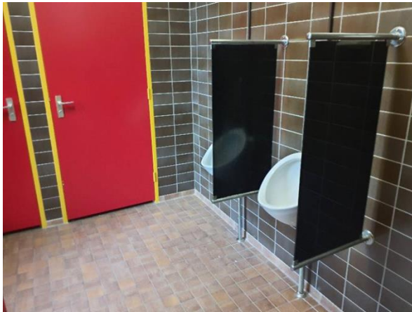
FB05: Achter het tegelwerk is geen inspectie mogelijk.
