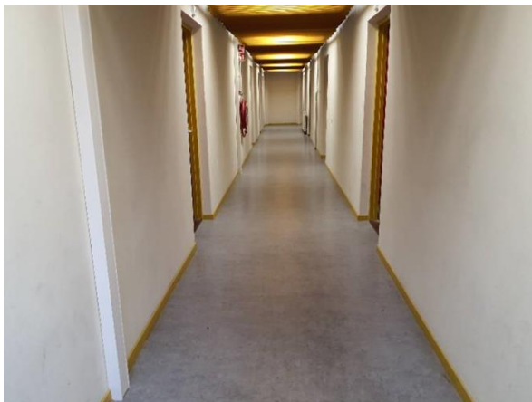
FB06: Onder de zichtbare vloerafwerkingen is geen inspectie mogelijk.
