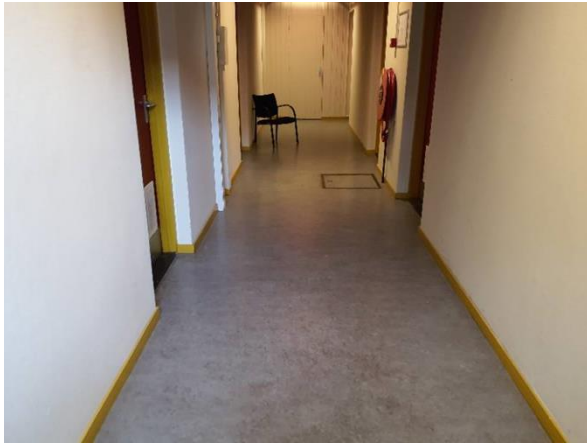
FB07: Onder de zichtbare vloerafwerkingen is geen inspectie mogelijk.
