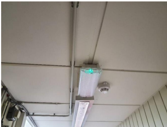
FB09: Boven vaste plafonds is geen inspectie mogelijk.
