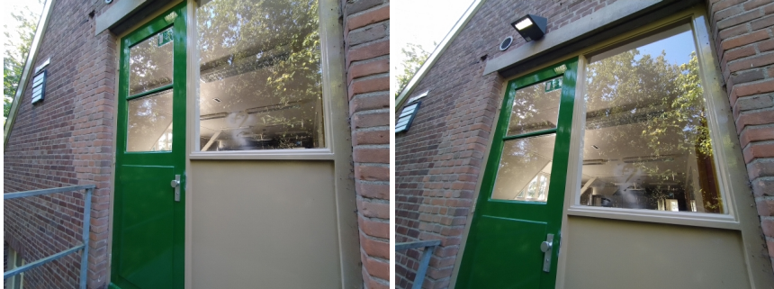
Opmerkingen Achtergevel 2 nooddeuruitgangen beneden- en bovenverdieping
