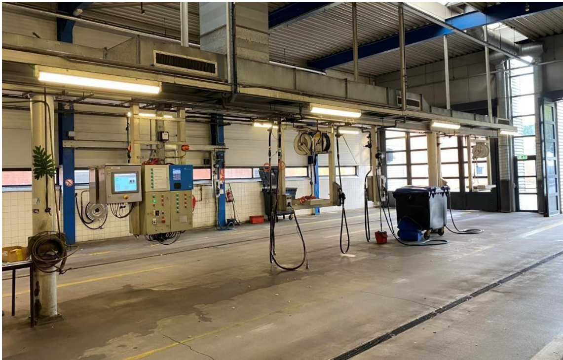
Figuur 5 - garage West, tankplaats gedeelte van de tank- en washal
