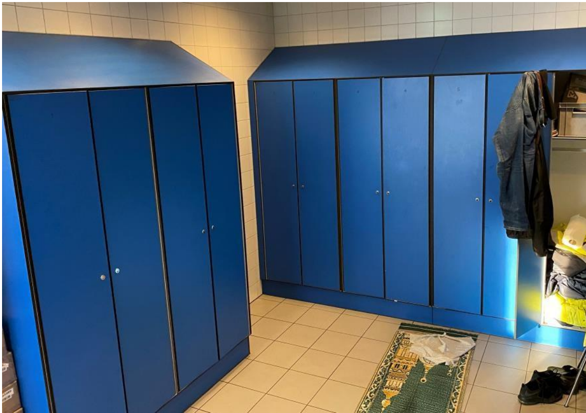
Figuur 17 - garage Zuid, kleedruimte
