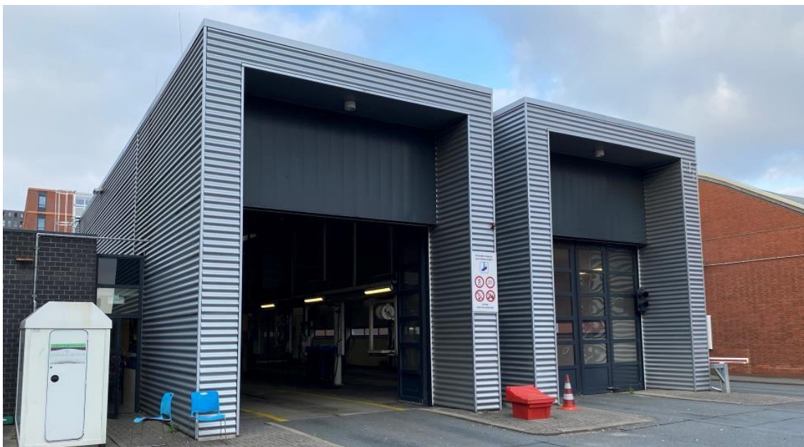
Figuur 4 - garage West, aanzicht tank- en was doorrijhal, men komt eerst langs het tankgedeelte en dan langs het wasgedeelte
