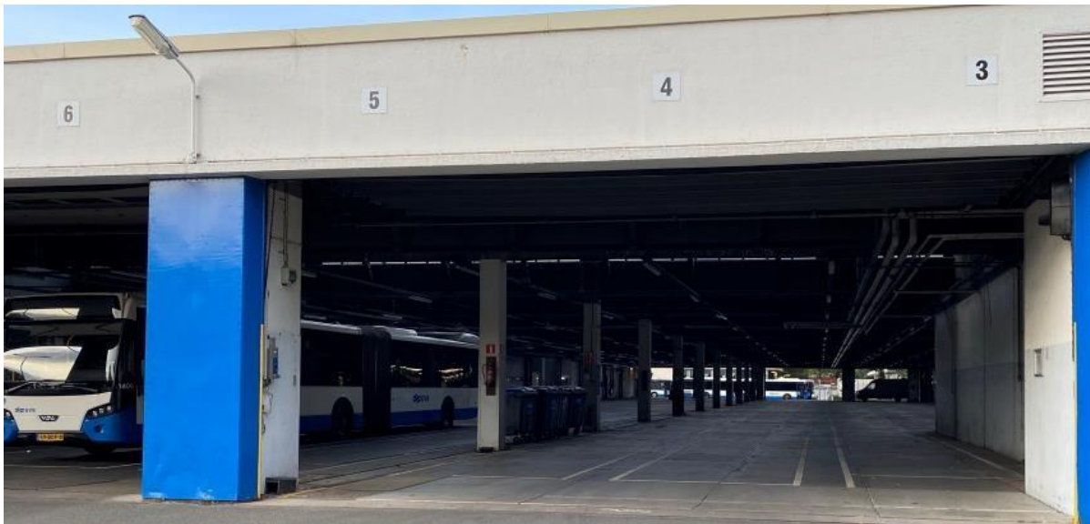
Figuur 11 - garage West, er zijn 18 banen voor het stallen van bussen, nog niet alle banen zijn geschikt voor elektrische bussen
