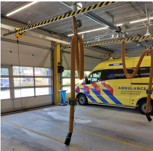
figuur 1 | Voorbeeld van bronafzuiging middels een uitlaatgasinstallatie.
