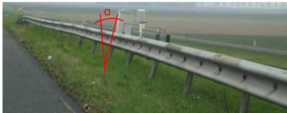
Afbeelding 7 Scheefstand van een geleiderail
