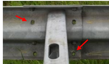
A fbeelding 13 Bevestigingsmiddelen ontbreken
