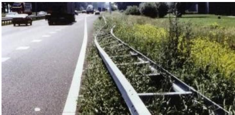
Afbeelding 21 Scheefstand klasse V
