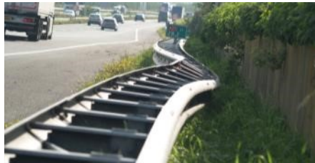
Afbeelding 17 Beschadigde geleiderailconstructie
