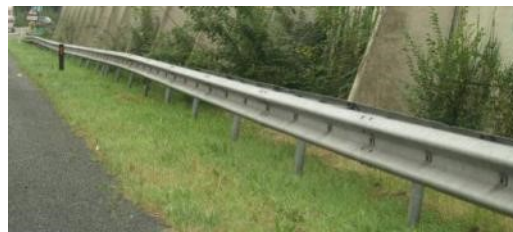
Afbeelding 22 Scheefstand klasse III/IV
