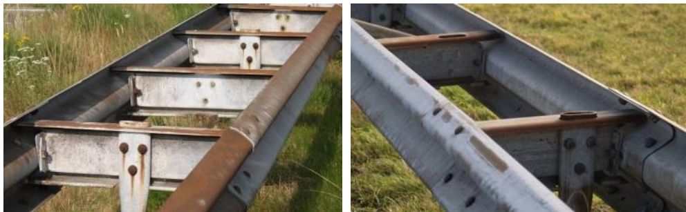
Afbeelding 32 Roestvorming geleiderail
