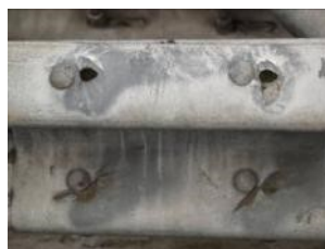
Afbeelding 9 Ernstige hak en slijpsporen
