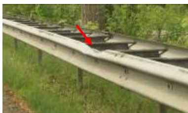
Afbeelding 8 Beschadigde plank
