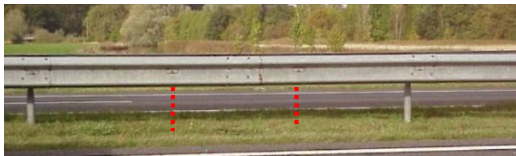
Afbeelding 18 De schuifconstructie, extra palen ontbreken voor ondersteuning
