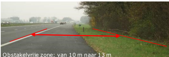
Obstakelvrije zone: van 10 m naar 13 m Afbeelding 15 Bomen staan door de gewijzigde norm in de obstakelvrije zone
