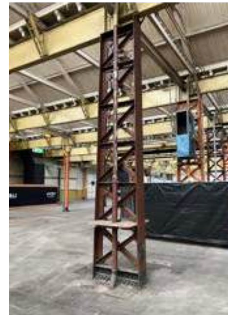
Vakwerk: aansluiting wagenmakerij II en III.
