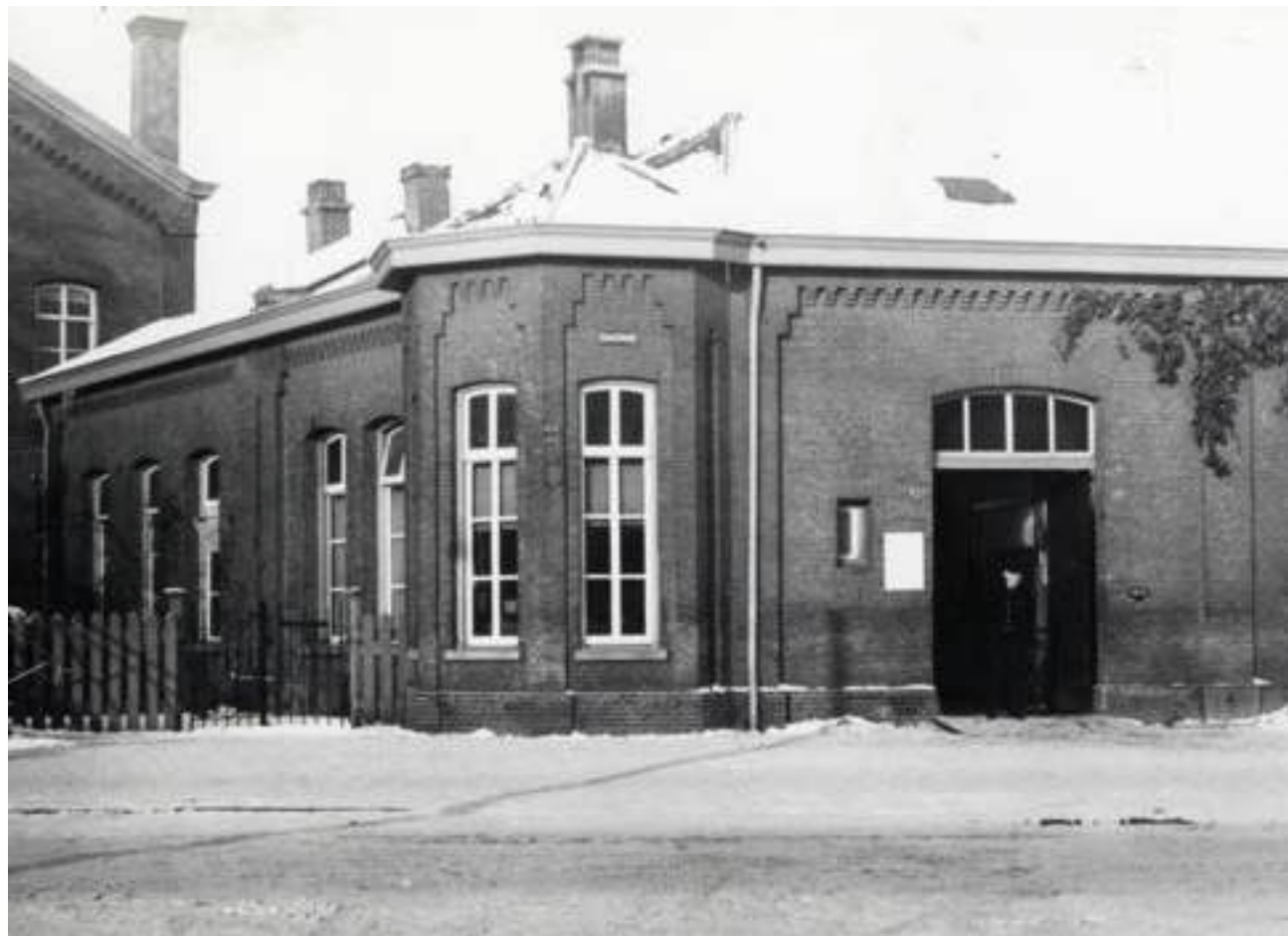
Gezicht op de portiersloge van de Centrale Werkplaats van de N.S. te Tilburg. Links op de foto nog met de voormalige woning van de chef werkplaats. 1939. Foto: onbekend. <HUA>
