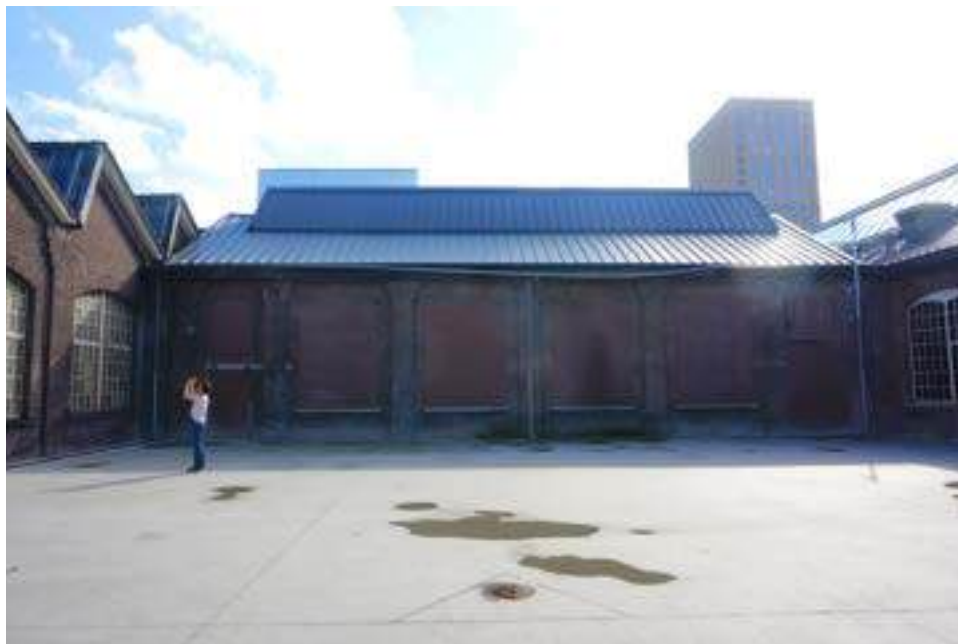
ZH. 2 gevel Schilderswerkplaats.
