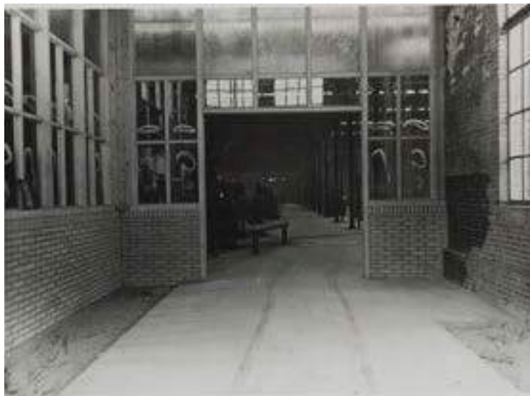
Verbouwing kopzijde rolwagenbaan zuidzijde Wagenmakerij, 1951. Foto: Spoorwegmuseum. <GVN>
