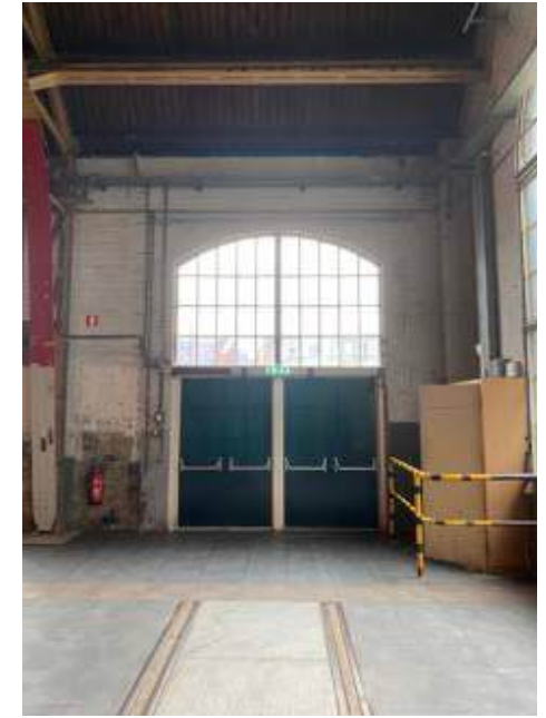
K. 9 deuren oostgevel.
