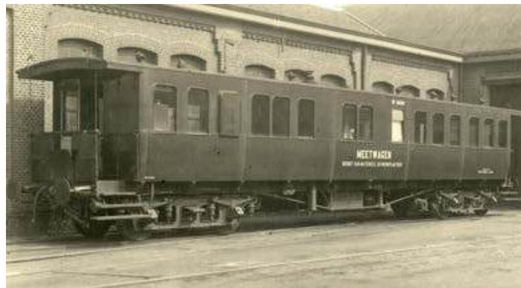
Meetwagen (dynamometerwagen) NS 169001 (ex-BC 1801) van de Dienst van Materieel en Werkplaatsen van de N.S. op het terrein van de Centrale Werkplaats te Tilburg (voor Wagenmakerij III), 1930-1940. Foto: W.F.H.J. Tabernaal. <HUA>
