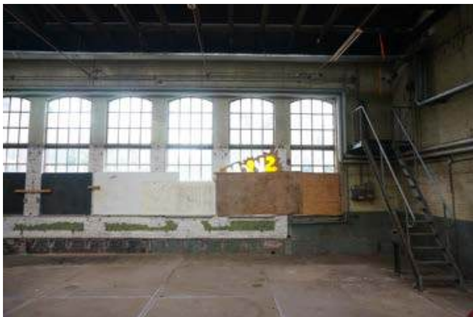
W. 46 zuidgevel met balk balkinkassingen.
