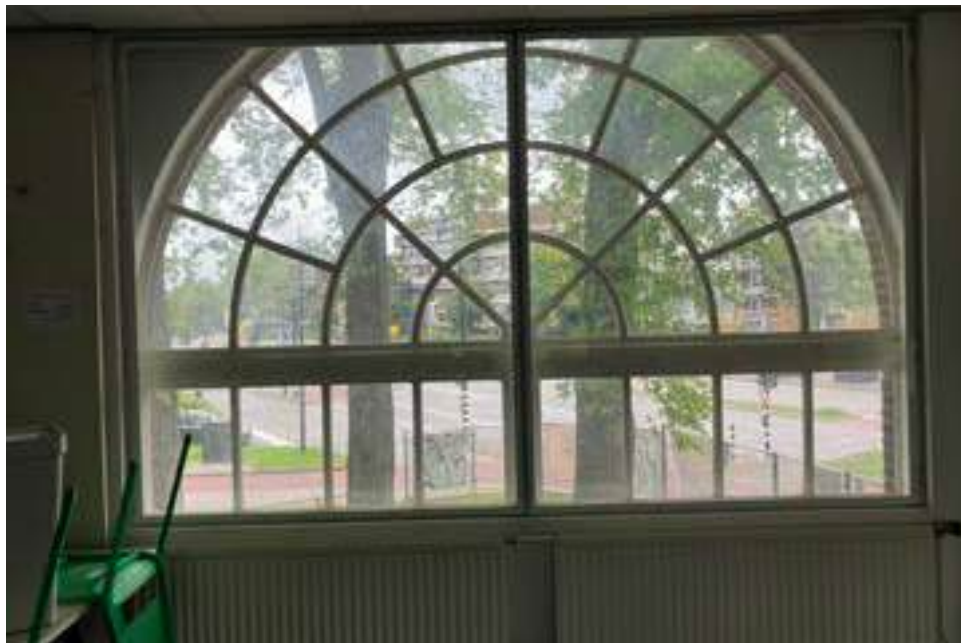
K. 12 achterzetramen noordgevel.
