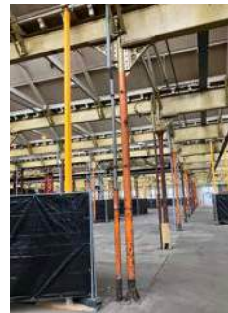
Vervangen kolom.
