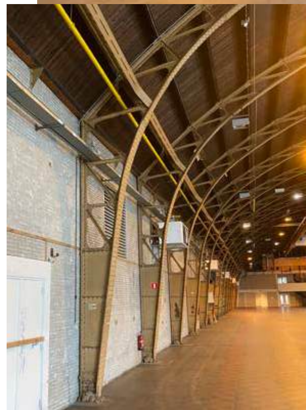
Constructie Koepelhal, 2023. Foto: Contrei
