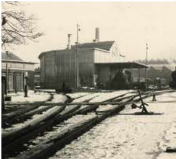
Gezicht op de polygonale locomotiefloods van de Centrale Werkplaats van de N.S. te Tilburg, 1939. Foto: onbekend. <HUA>
