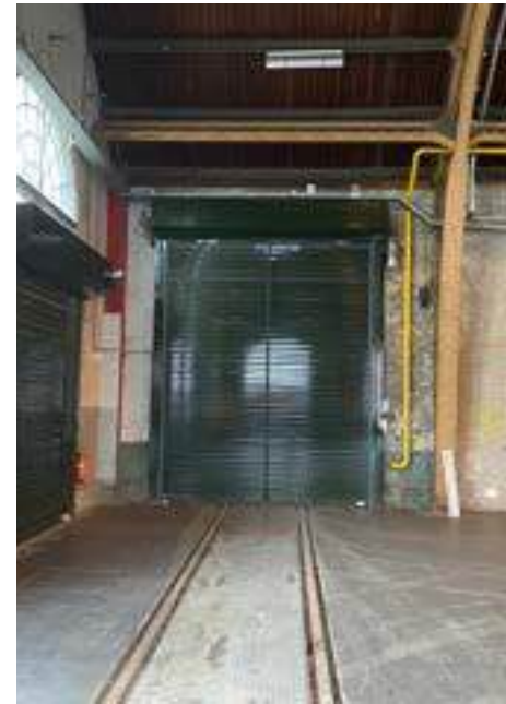
K. 8 deur westgevel.
