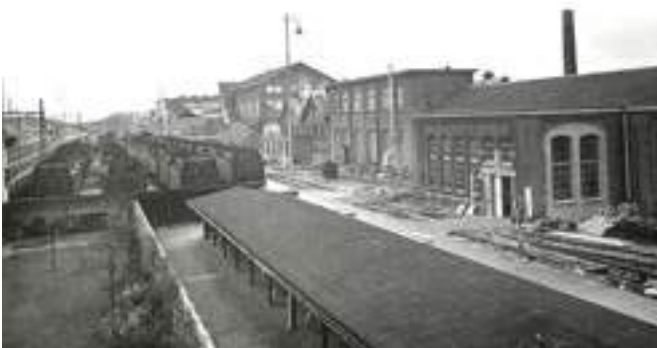
Gezicht op de centrale werkplaats van de N.S. te Tilburg, 1951. Foto: W.P.F.M. van Schaik. <HUA>
