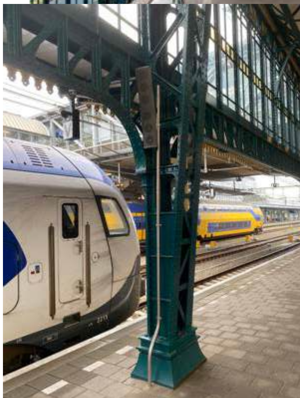
Constructie perronoverkapping 's-Hertogenbosch, 2023. Foto: Contrei
