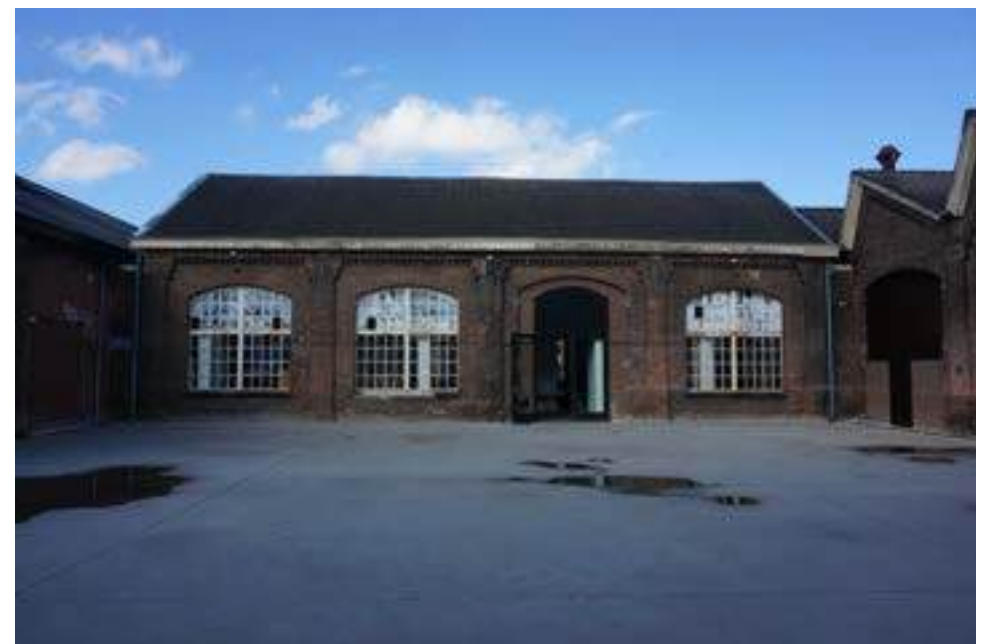
ZH. 3 gevel Bankwerkerij.
