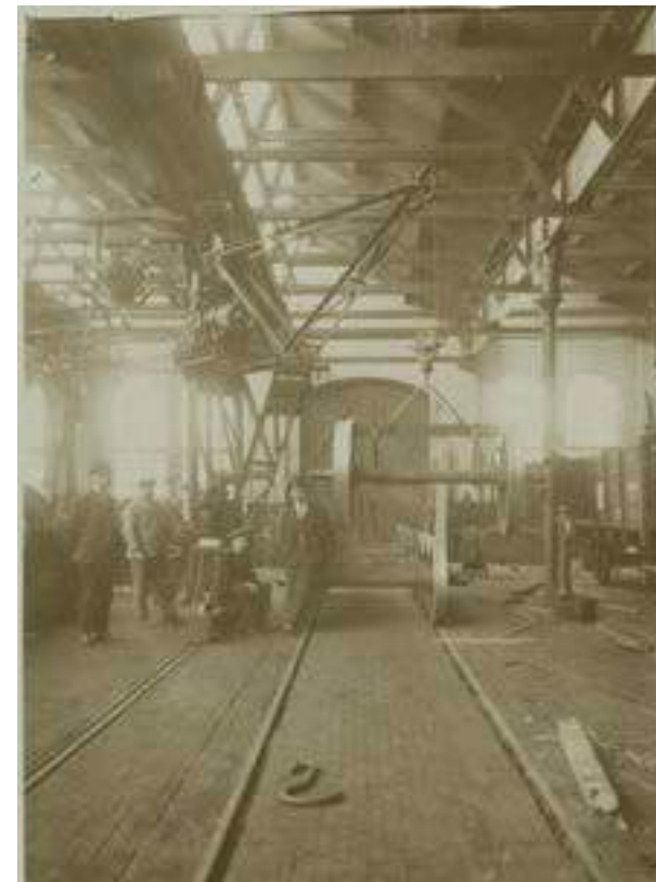
Interieur Wagenwerkplaats Blerick, 1924. Foto: Spoorwegmuseum. <GVN>
