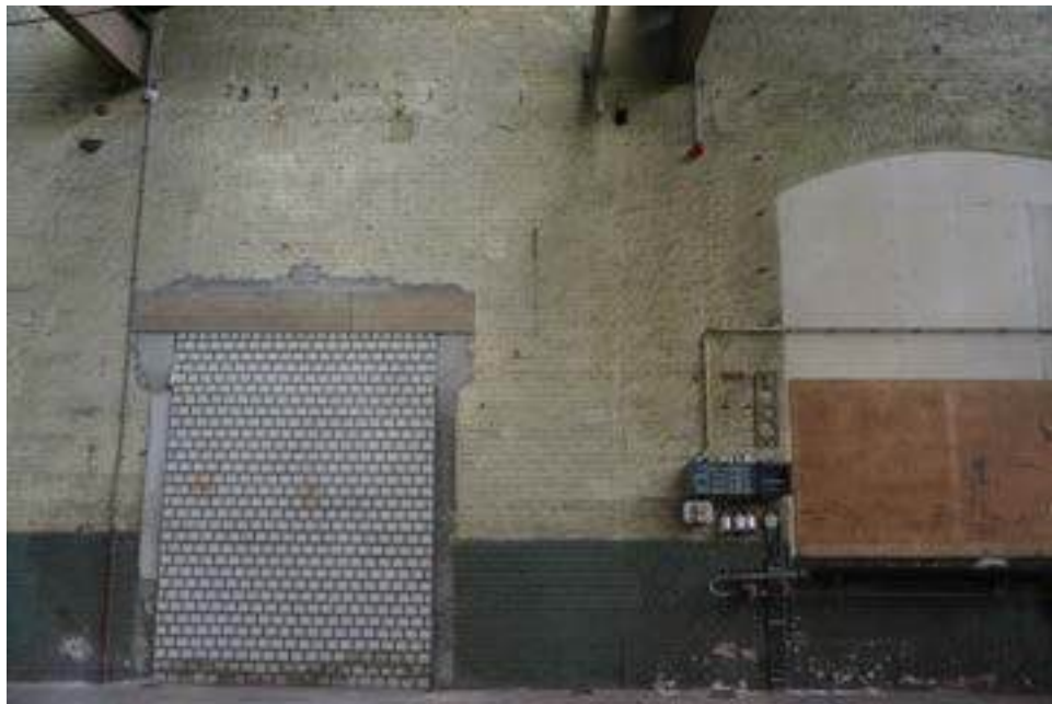
W. 44 oorspronkelijke doorgang (dichtgezet) met daarin een tijdens fase 4 dichtgezette opening.
