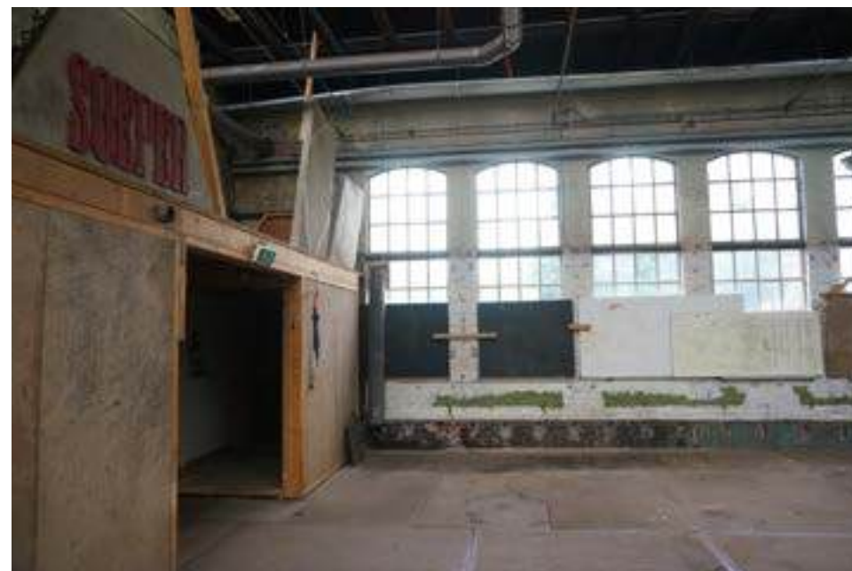
W. 47 links het houten entreehok.
