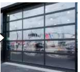
scheiding Rolwagenbaan: hergebruikte Sprinterramen in overheaddeuren
