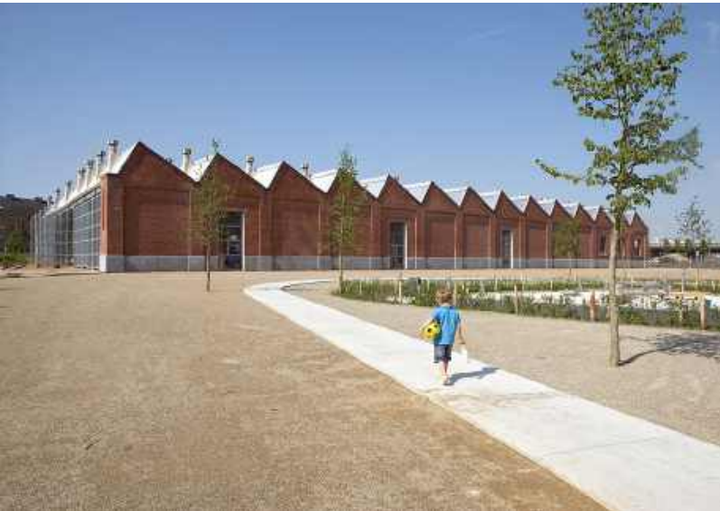
renovatie SPTM-loods, Antwerpen (BE)
