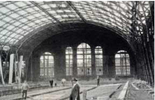
Het wegnemen van het kantoorblok geeft ons de mogelijkheid beide oorspronkelijke kopgevels te herstellen als 'kerkramen van de industrie'.
