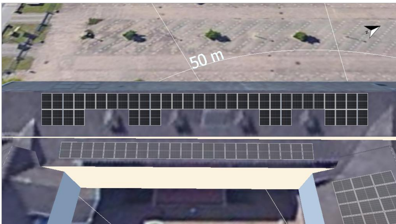
Afbeelding: 4. Modulevlak - Building 01-Roof Area Southeast
