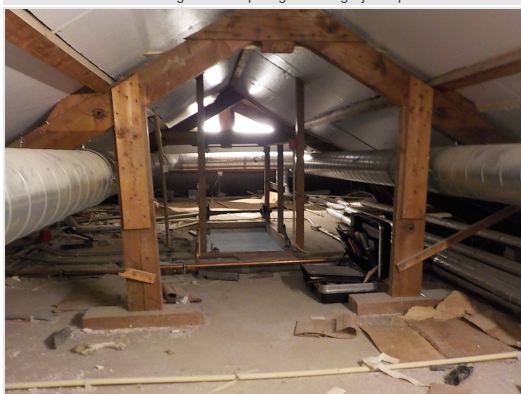
Vliering boven 1e etage: alle aanwezige stof/rommel/afval is onverdacht
