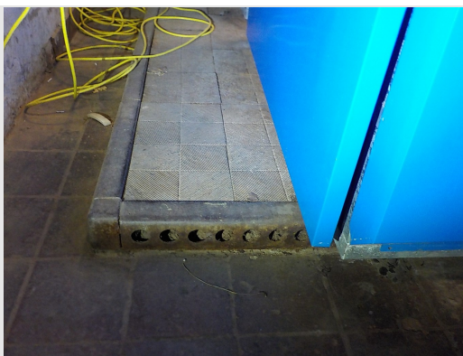
cv-ruimte: stalen vloerconstructie tbv cv-ketels
