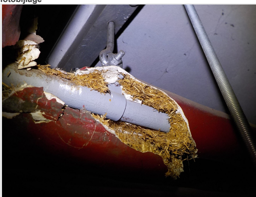
cv-ruimte: de leidingisolatie is onverdacht
