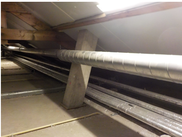
Het kanaal komt vanuit de onderliggende 1e etage (trace onbekend) en gaat door het dak heen
