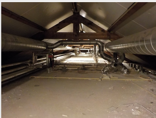
Vliering boven 1e etage: alle aanwezige stof/rommel/afval is onverdacht
