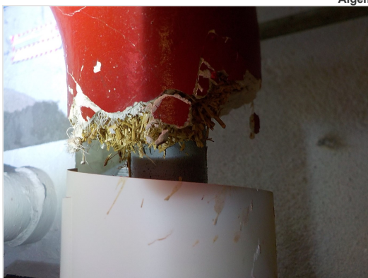
cv-ruimte: de leidingisolatie is onverdacht
