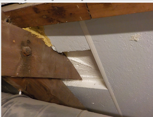
Vliering, met vernieuwd geïsoleerd dak
