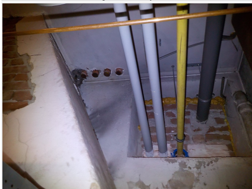
cv-ruimte: dichtgemaakte sparing naar mogelijk kruipruimte
