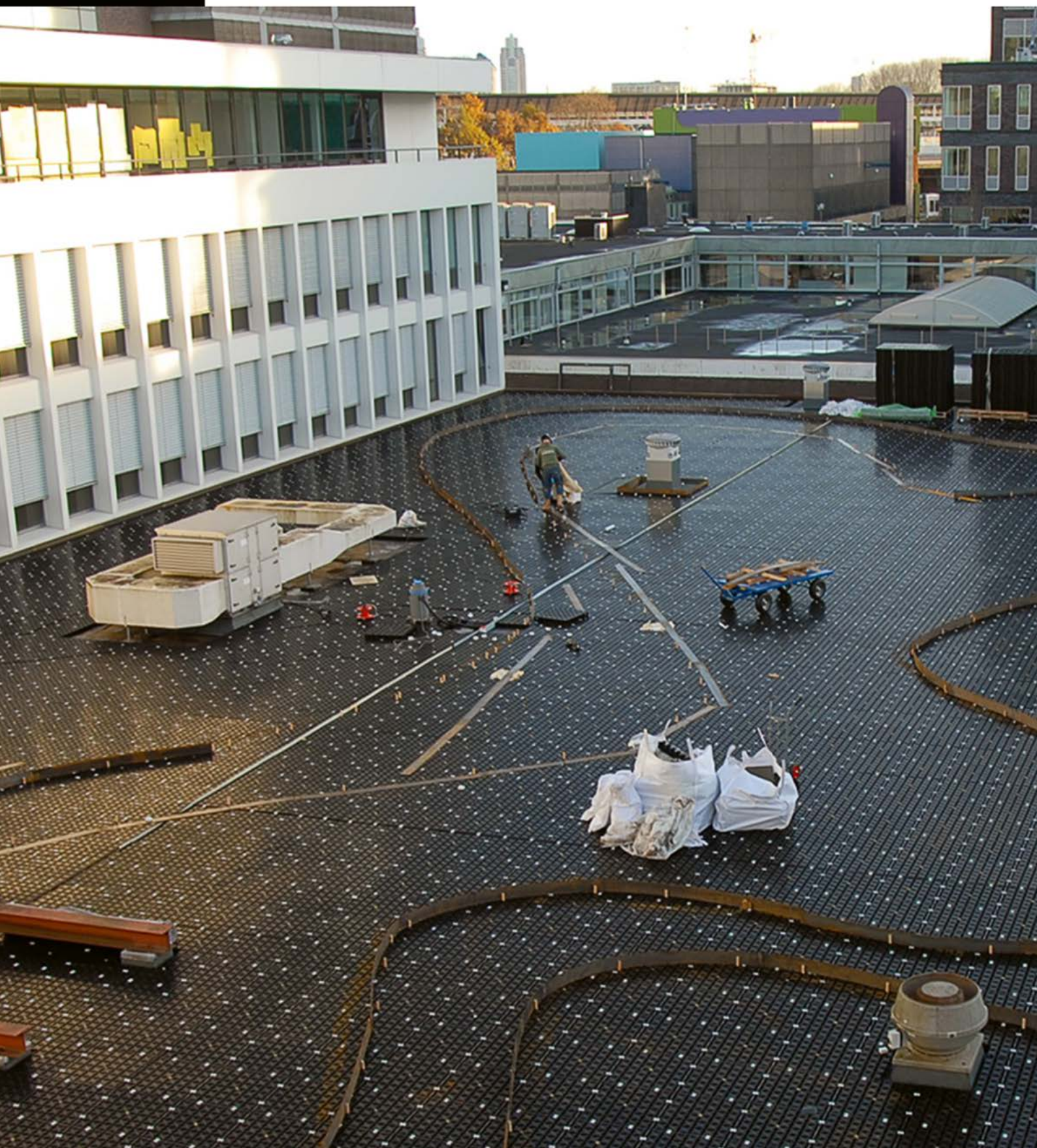
Realisatie retentiedak met infiltratiekragen en eindresultaat aan Antonio Vivaldistraat, Zuidas. (foto: Dakdokters Studio)
