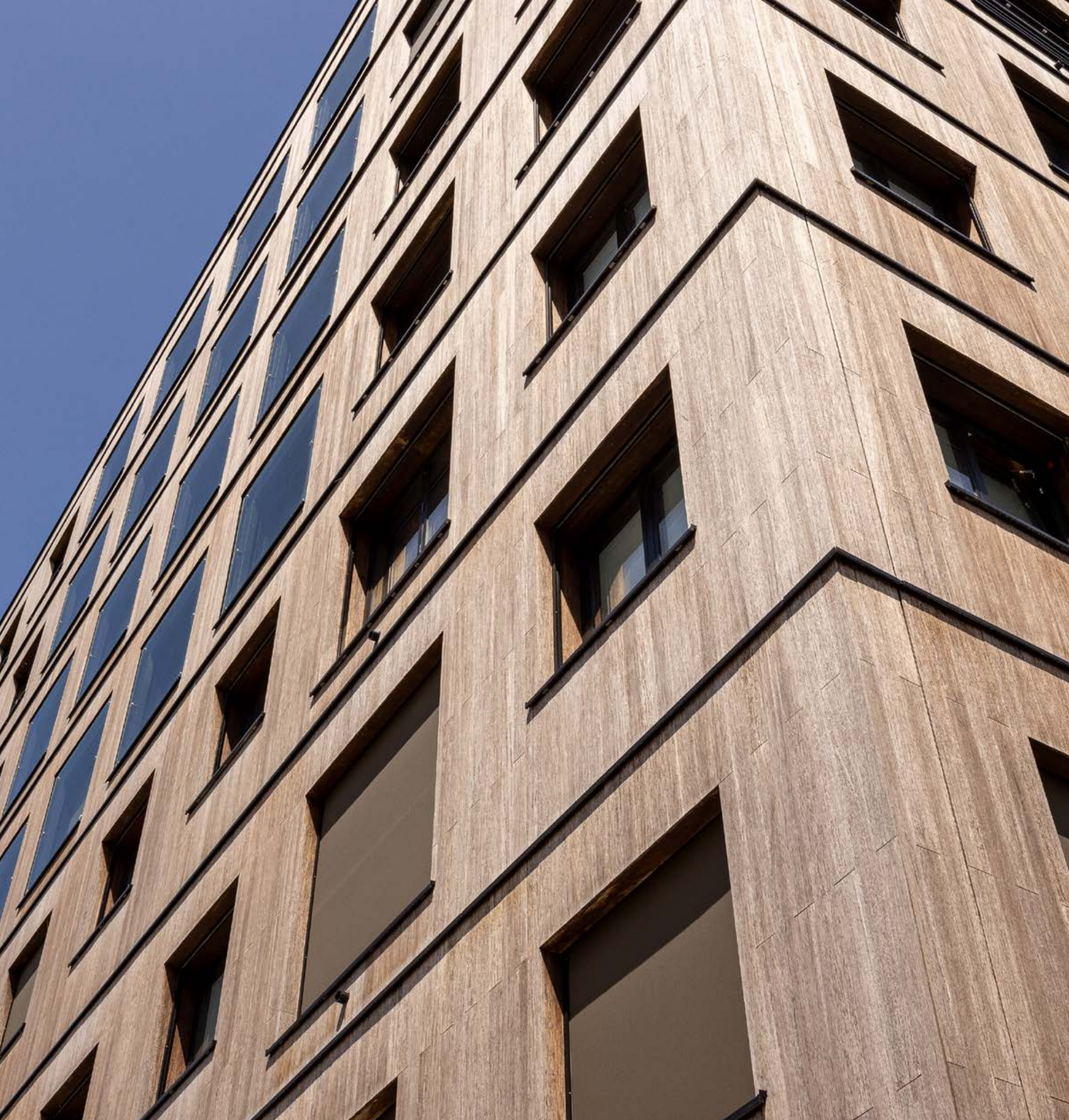
Hittewerend gevelmateriaal van hout. Gebouw Switi in Zuidoost.
