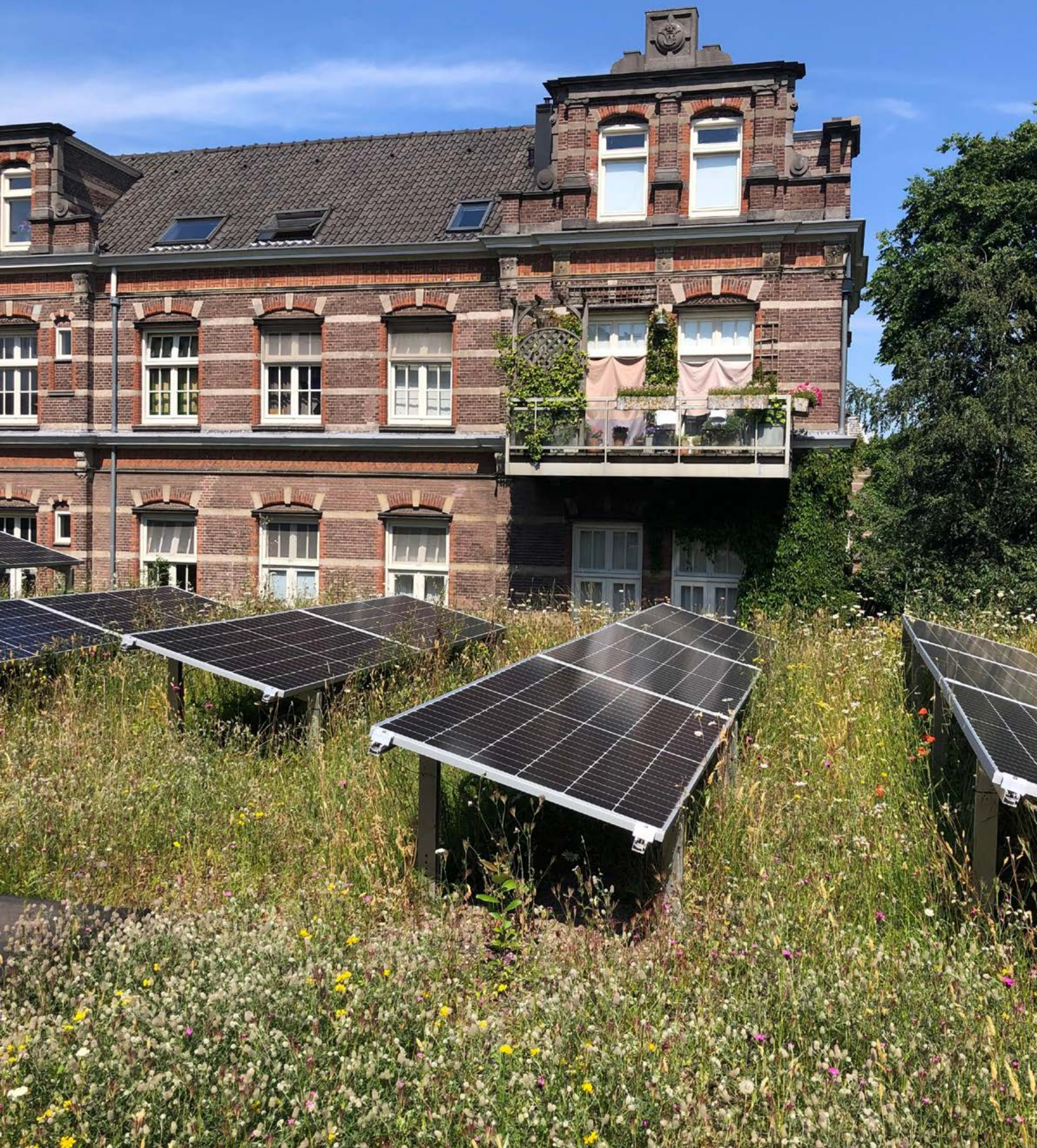
Groen- /natuurdak in combinatie met PV panelen (foto: Amsterdam Weerproof)
