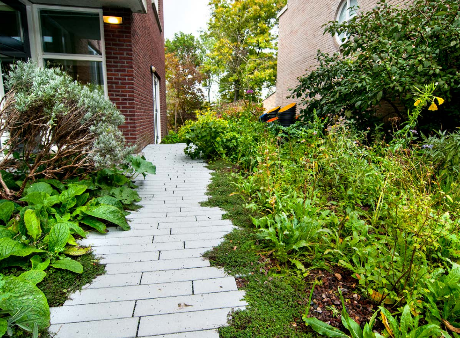
Waterpasserende verharding met goen. (foto: Amsterdam Weerproof)
