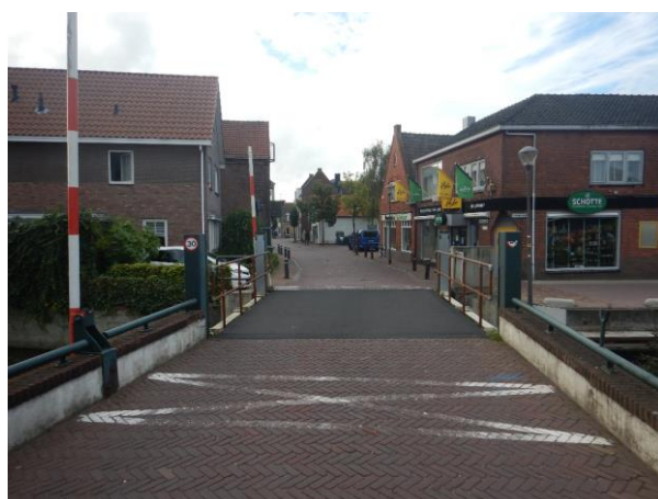
Figuur 2.3: Wegindeling op brugdek
