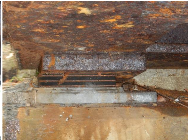
Figuur 2.20: Oplegging, niet centrisch
