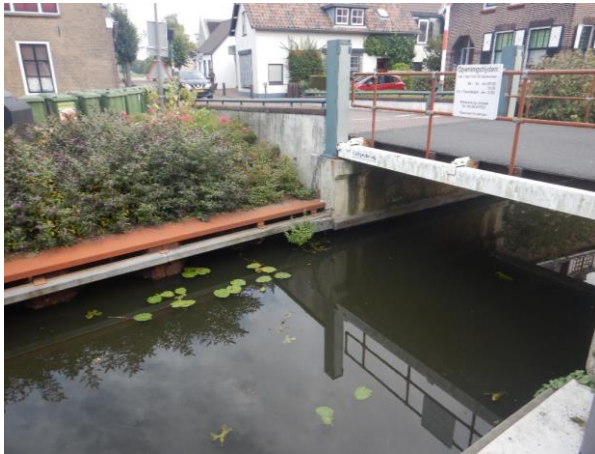
Figuur 2.9: Aansluiting op damwand noordwestzijde
