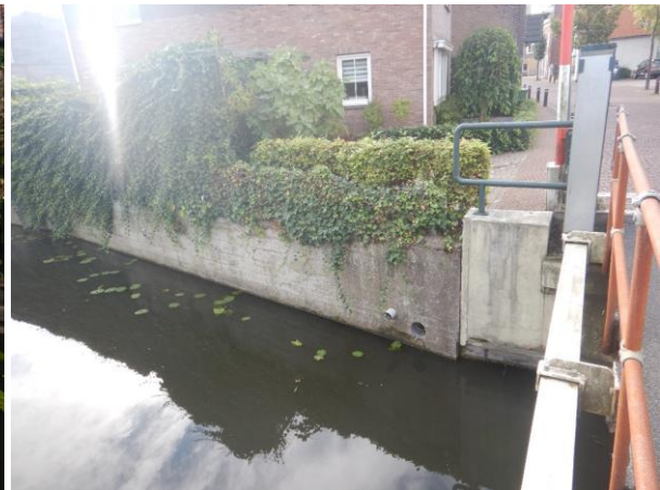
Figuur 2.12: Aansluiting op keermuur zuidoostzijde
