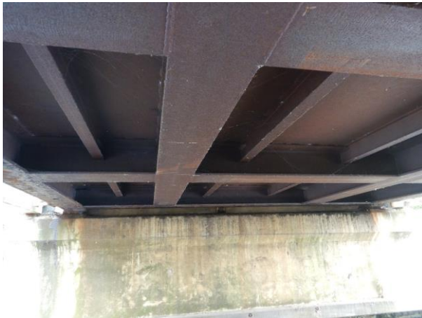
Figuur 2.19: Onderzijde val en opleggingen
