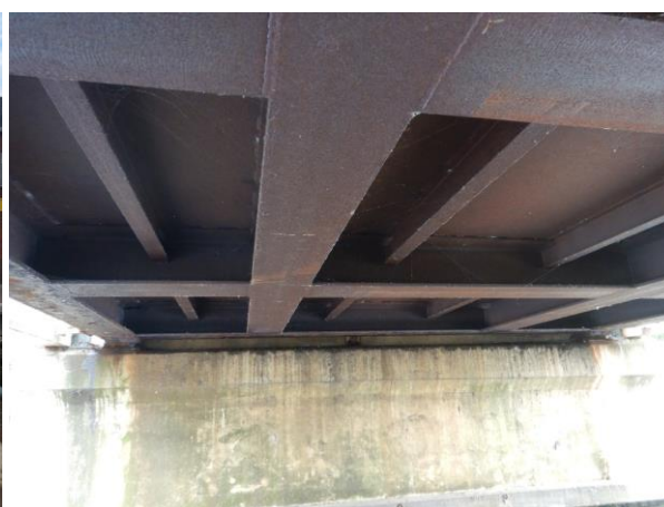
Figuur 2.4: Onderzijde brugdek
