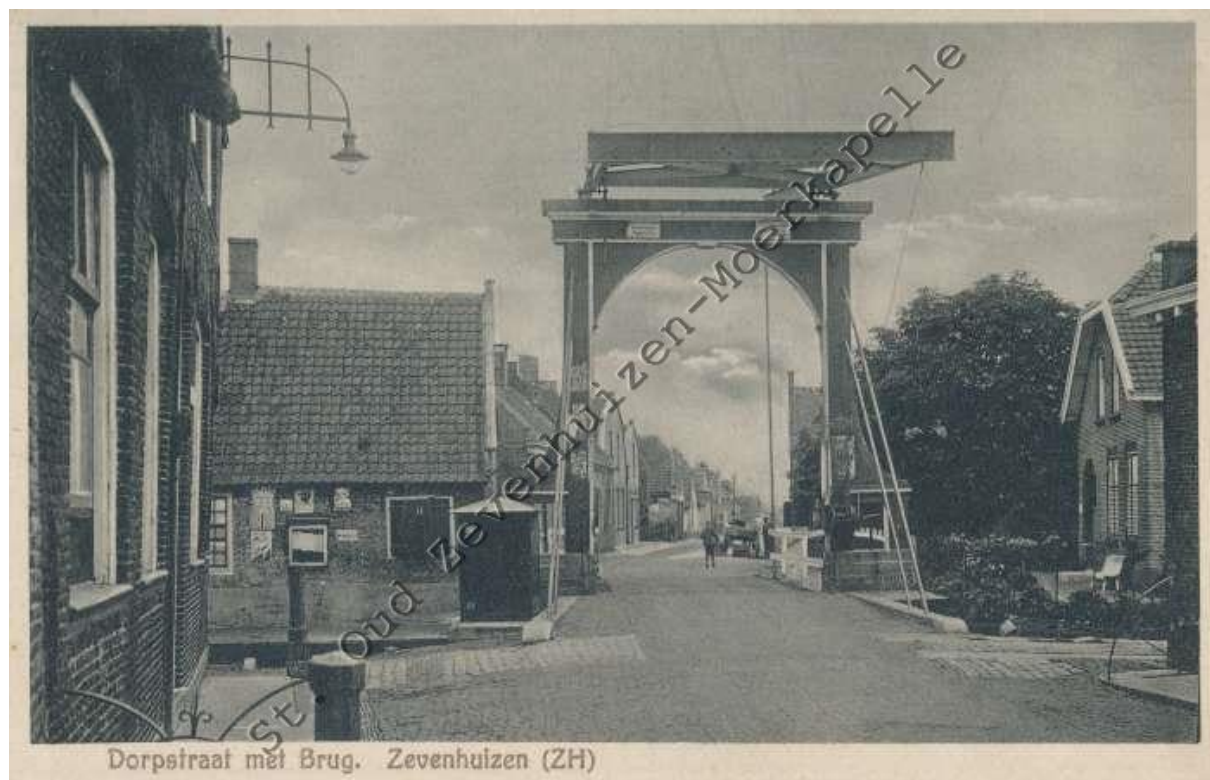
Figuur 2.5: De Catgesbrug richting het Noorden in 1932 ( www.beeldbankoudzevenhuizenmoerkapelle.nl )
