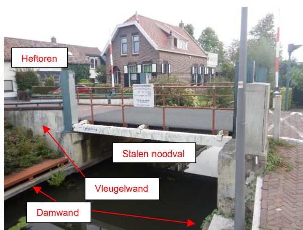
Figuur 2.6: Aanzicht brug
