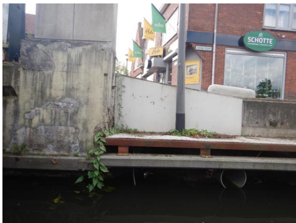
Figuur 2.16: Afsmeerlaag niet meer functioneel
