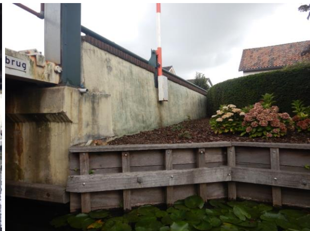
Figuur 2.15: Landhoofd monoliet verbonden met vleugelwand
