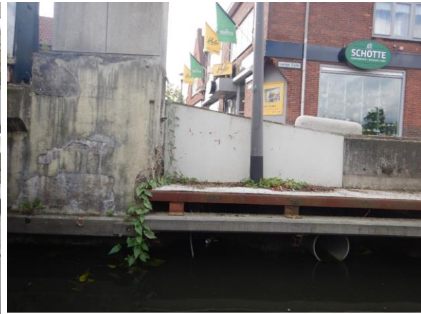
Figuur 2.10: Aansluiting op damwand zuidwestzijde
