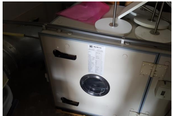
Figuur 2. Links: Onderdelen ventilatie- en koelsysteem in de bibliotheek boven. Rechts: deel van LBK.
