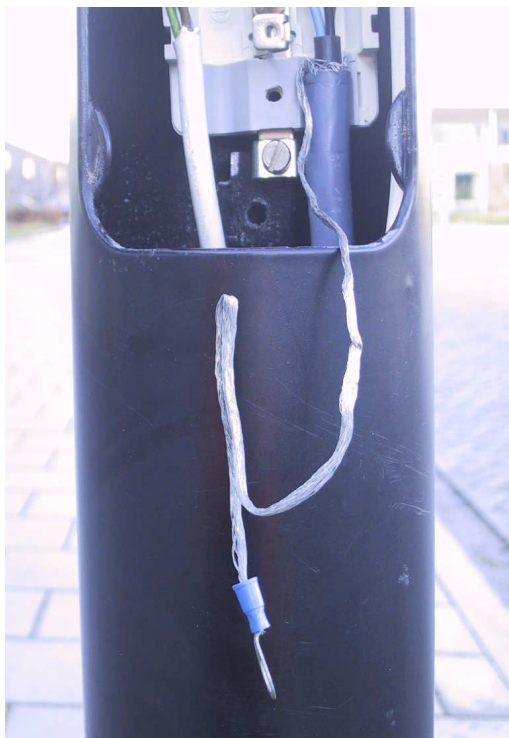
1. Grondkabel nulader (blauw links), nachtader (zwart midden) en avondader (bruin rechts) aansluiten. Aardleadse langs kabel terugleiden.
