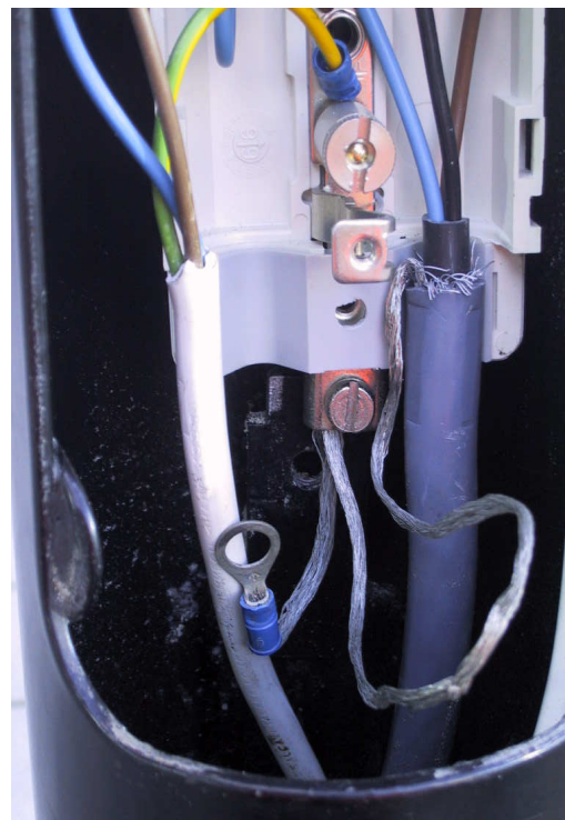
2. Dubbel gevouwen aardleadse monteren onder externe aardschroef paneel. Aarddraad armatuursnoer met perskabelschoen (pen) onder interne aardschroef.
