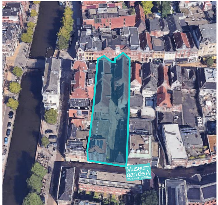
Afbeelding – bestaande situatie bouwblok
