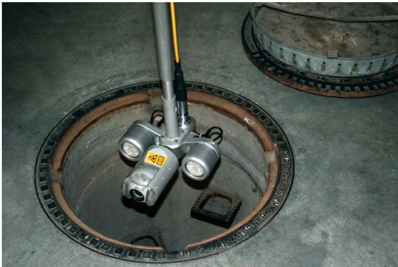
Figuur A Putvideo-inspectie (traditioneel) (Foto: IBAK)
