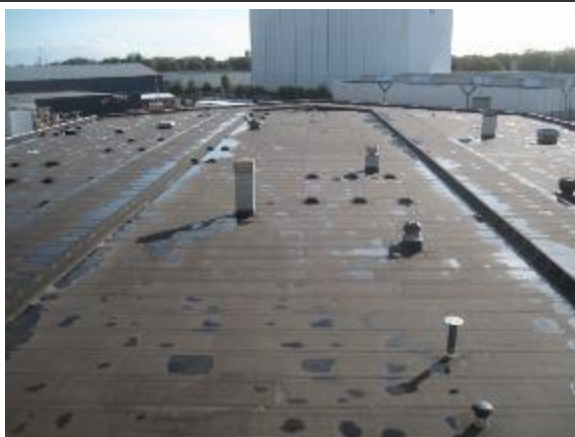
Impressie van een van de daken
