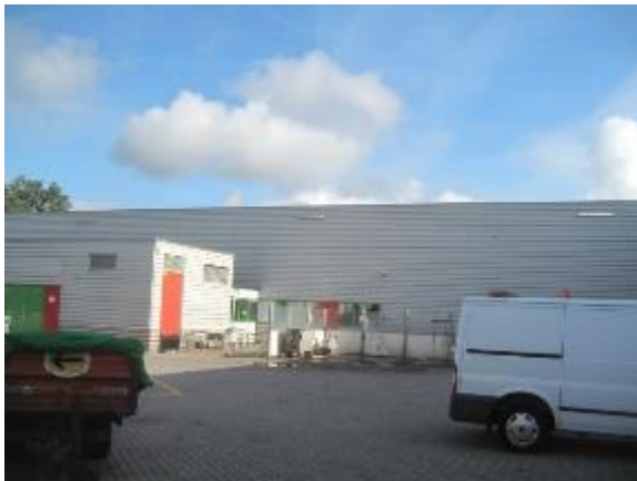
Gevel gebouw 8 met uitbouw van opslag incourant materiaal
