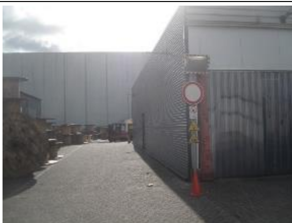
Gevel gebouw 7 met links opslag
