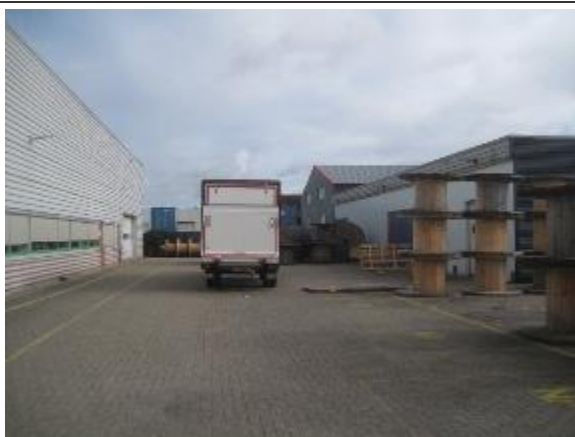
Links gebouw 8, rechtsgebouw 7 met onder handen werk
