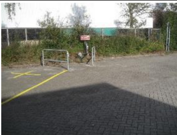
Gevel gebouw 4 en 3
