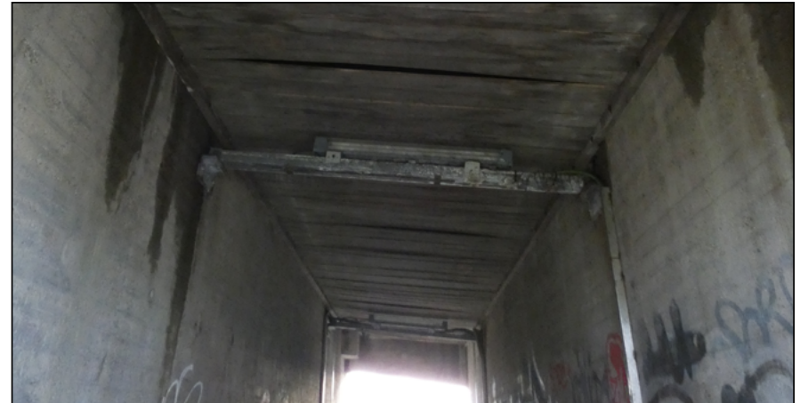
Figuur: infrastructurele objecten. Objecten zoals bruggen en tunneltjes kunnen door de aanwezigheid van spleten en kieren ook fungeren als verblijfplaatsen voor vleermuizen of broedvogels.
