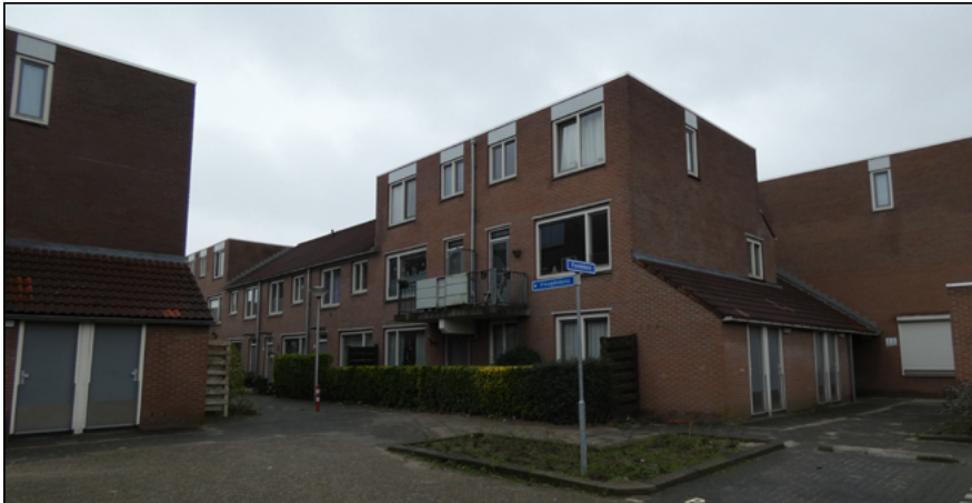
Figuur: veelvoorkomende bebouwing. Gebouwen hebben deels schuine dakpandaken en deels platte daken. Huismussen, gierzwaluwen, andere broedvogels en vleermuizen kunnen hier in verblijven hebben.
