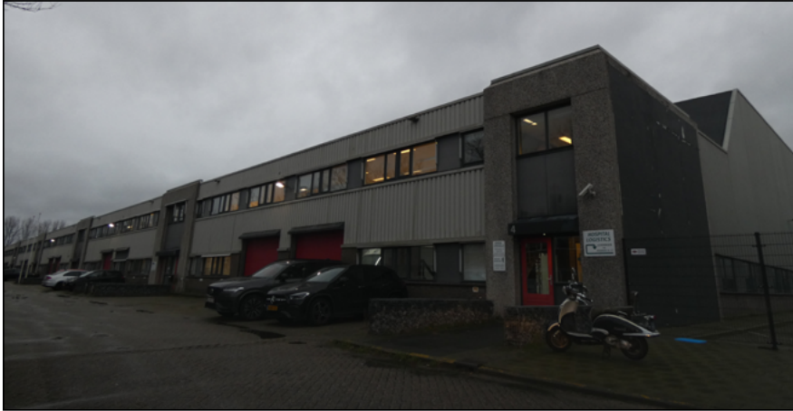
Figuur: veelvoorkomende bebouwing. Gebouwen op bedrijventerreinen en industrieterreinen hebben veelal een plat dak. Soms bevatten ze open stootvoegen, waar vleermuizen gebruik van kunnen maken.
