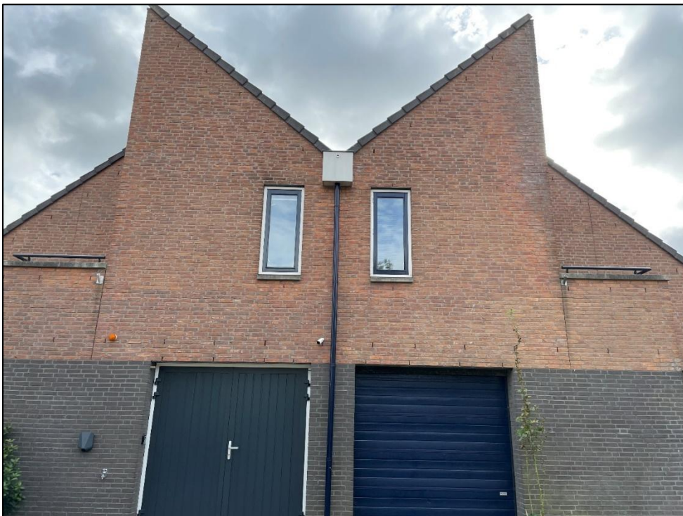
Figuur 8: Open stootvoegen zijn geschikte openingen voor vleermuizen om de spouw te betreden.
