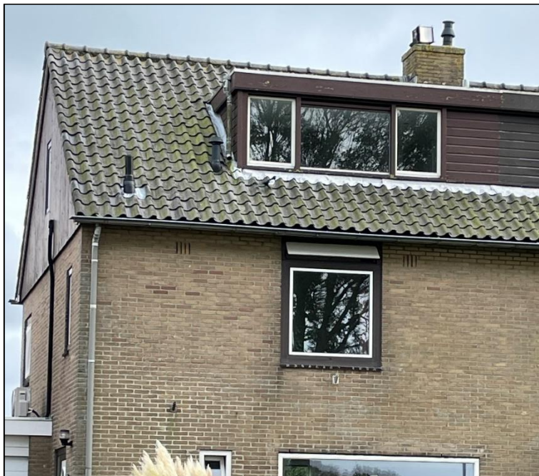
Figuur 8: Open stootvoegen zijn geschikte openingen voor vleermuizen om de spouw te betreden.
