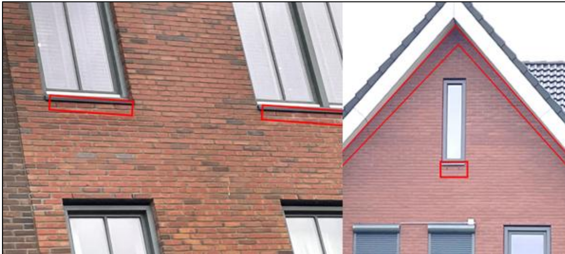
Figuur 8: Open stootvoegen zijn geschikte openingen voor vleermuizen om de spouwte betreden.
