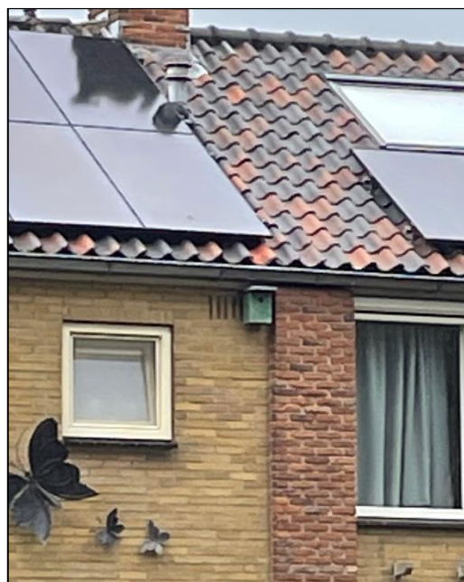
Figuur 7: Via ventilatievoegen kunnen vleermuizen de spouw betreden.
