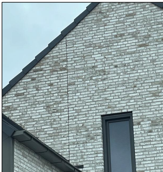
Figuur 10: Dilatatievoegen zijn geschikte openingen voor vleermuizen om de spouwte betreden.
