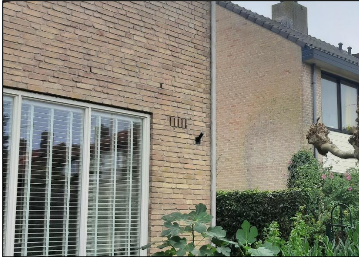
Figuur 12: Open stootvoegen zijn geschikte openingen voor vleermuizen om de spouw te betreden.
