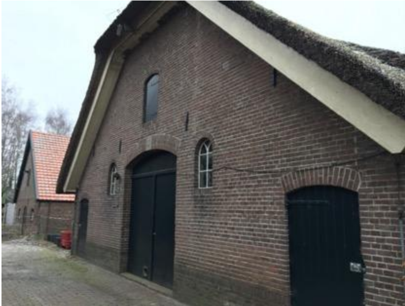
Figuur 4 Voorbeeld kopse gevel met dakoverstek
