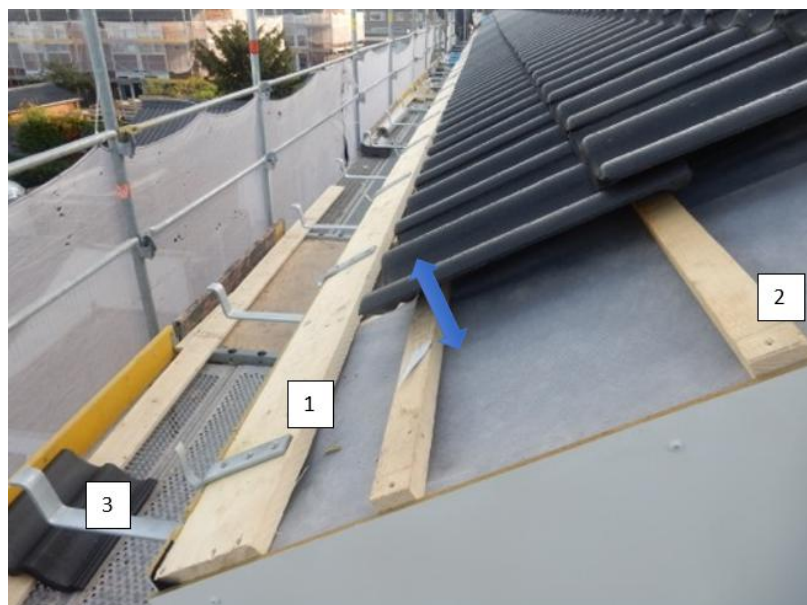
Figuur 1 Profilering van de ruimte onder de dakpannen (pijl). De onderste rij dakpannen (1) is nog niet geplaatst. De onderste rij pannen ligt straks over de gootplank (3). Er is in de nieuwe situatie evenveel broedruimte als in de oude situatie aanwezig: de panlatten (2) rusten nu op de isolatiebepaling in plaats van het dakbeschoot. Uiterst links zijn de beugels voor de ondiepe dakgoot zichtbaar (3). De verticale afstand tussen de bodem van de goot en de ingang onder de onderste rij dakpannen (nog niet geplaatst) is niet te groot voor huismussen. Bij deze situatie is de kopse gevel niet met metselwerk aangeheeld maar afgedekt met trespas. Foto: E-consultancy.
