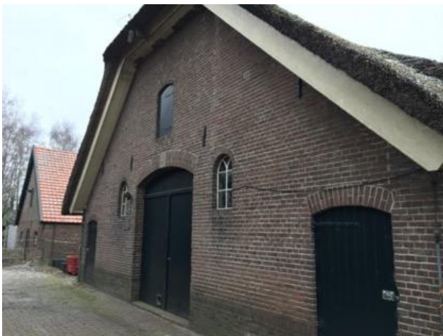
Figuur 4 Voorbeeld kopse gevel met dakoverstek
