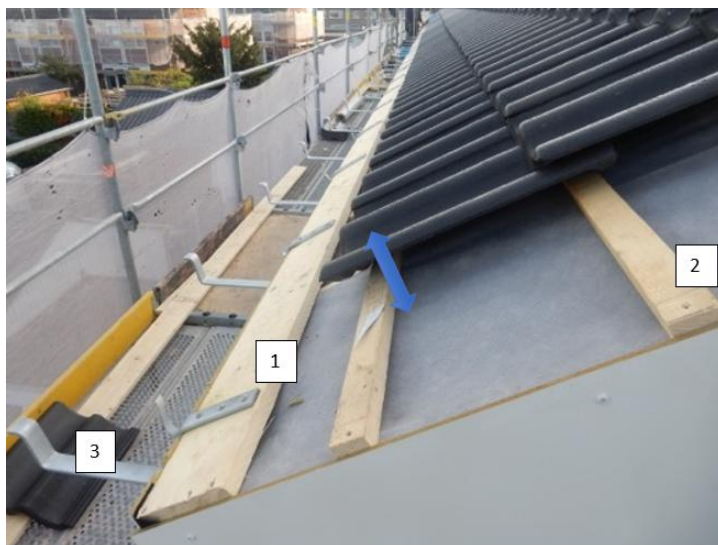
Figuur 1 Profilering van de ruimte onder de dakpannen (pijl). De onderste rij dakpannen (1) is nog niet geplaatst. De onderste rij pannen ligt straks over de gootplank (3). Er is in de nieuwe situatie evenveel broedruimte als in de oude situatie aanwezig: de panlatten (2) rusten nu op de isolatiebeplating in plaats van het dakbeschoot. Uiterst links zijn de beugels voor de ondiepe dakgoot zichtbaar (3). De verticale afstand tussen de bodem van de goot en de ingang onder de onderste rij dakpannen (nog niet geplaatst) is niet te groot voor huismussen. Bij deze situatie is de kopse gevel niet met metselwerk aangeheeld maar afgedekt met trespas. Foto: E-consultancy.
