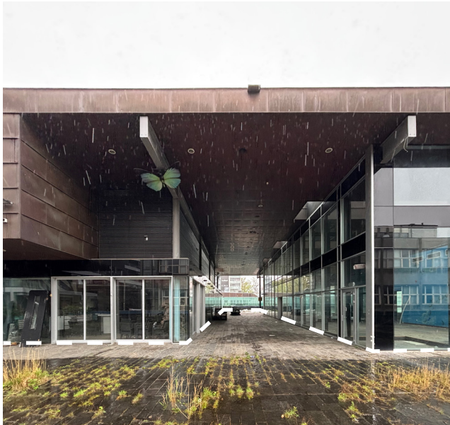
Binnenstraat / dakterras op de 1 e verdieping
