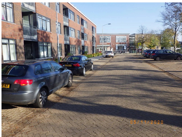
Nr 3: Restanten chroom 6 houdende verf verwijderd.
