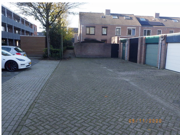
Nr 9: Restanten chroom 6 houdende verf verwijderd.
