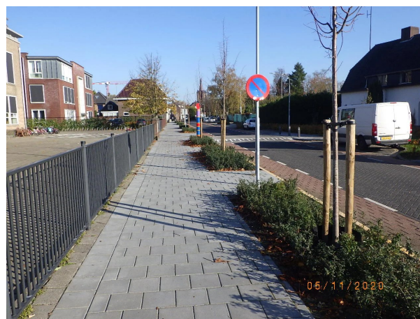
Nr 12: Restanten chroom 6 houdende verf verwijderd.
