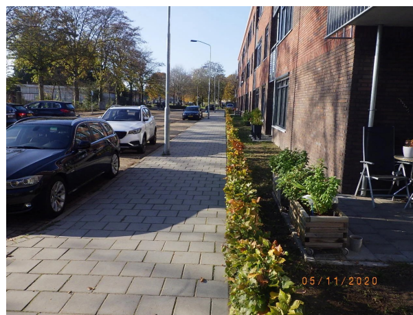
Nr 6: Restanten chroom 6 houdende verf verwijderd.
