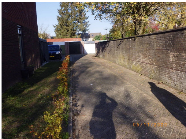
Nr 7: Restanten chroom 6 houdende verf verwijderd.
