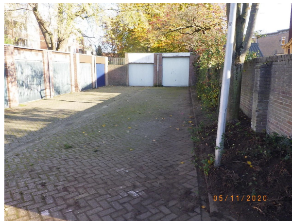
Nr 8: Restanten chroom 6 houdende verf verwijderd.
