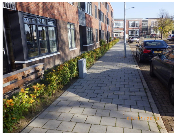
Nr 4: Restanten chroom 6 houdende verf verwijderd.
