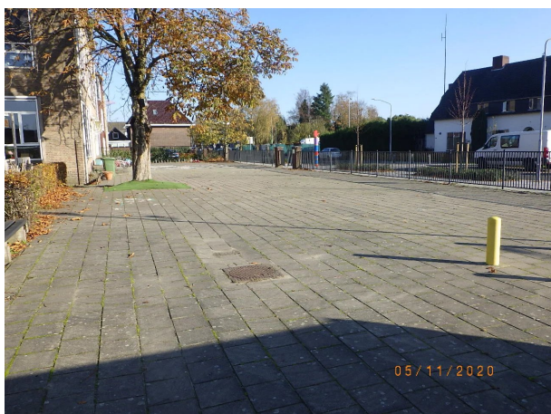
Nr 11: Restanten chroom 6 houdende verf verwijderd.
