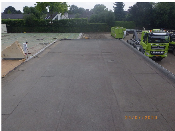
Nr 21: Lekdorpel, Hoekprofiel en damwandprofielen met chroom6 houdende verlaag verwijderd platdak (fase 5)
