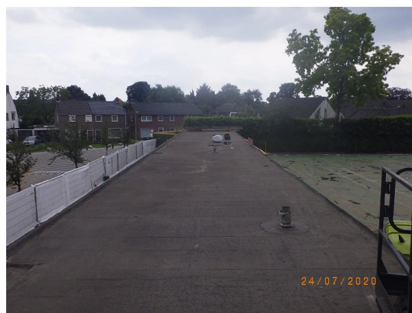
Nr 18: Lekdorpel, Hoekprofiel en damwandprofielen met chroom6 houdende verlaag verwijderd platdak (fase 5)
