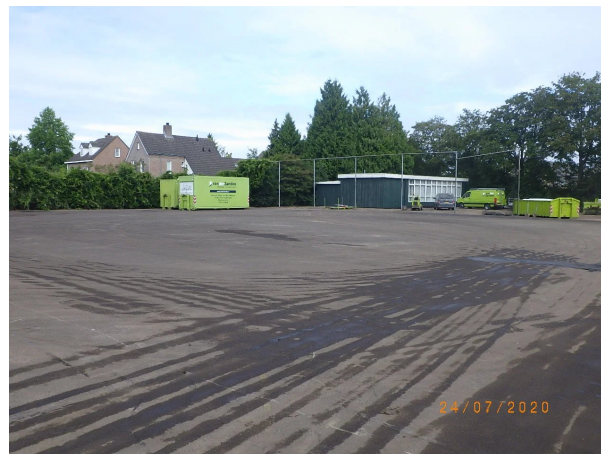
Nr 6: Chroom 6 houdende verf restanten verwijderd sportveld (fase 2)
