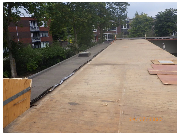
Nr 20: Lekdorpel, Hoekprofiel en damwandprofielen met chroom6 houdende verlaag verwijderd platdak (fase 5)
