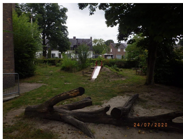
Nr 12: Chroom 6 houdende verf restanten verwijderd speeltuin kinderopvang (fase 4)
