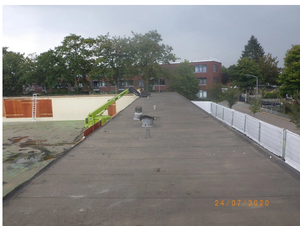
Nr 17: Lekdorpel, Hoekprofiel en damwandprofielen met chroom6 houdende verlaag verwijderd platdak (fase 5)
