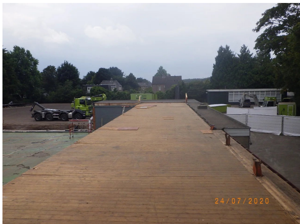
Nr 19: Lekdorpel, Hoekprofiel en damwandprofielen met chroom6 houdende verlaag verwijderd platdak (fase 5)
