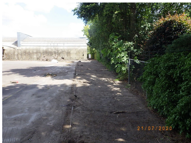
Nr 7: Toplaag met restanten chroom6 verf verwijderd van het maaiveld.
