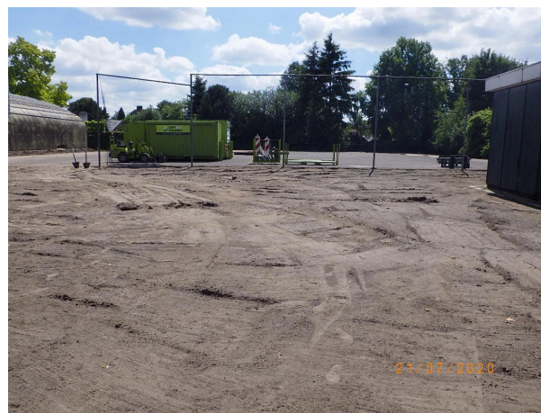
Nr 4: Toplaag met restanten chroom6 verf verwijderd van het maaiveld.
