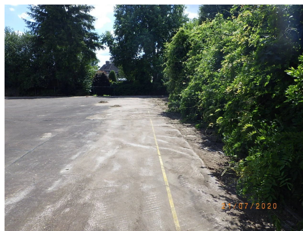
Nr 6: Restanten chroom6 verf verwijderd van het maaiveld.
