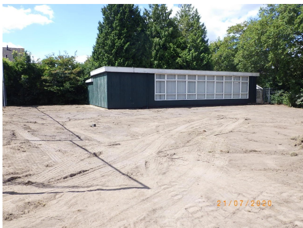
Nr 3: Toplaag met restanten chroom6 verf verwijderd van het maaiveld.
