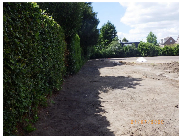
Nr 8: Toplaag met restanten chroom6 verf verwijderd van het maaiveld.
