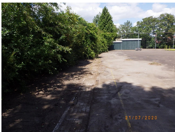
Nr 5: Restanten chroom6 verf verwijderd van het maaiveld.
