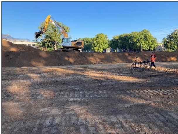
Figuur 13. Non-realtime passieve detectie met handkar
