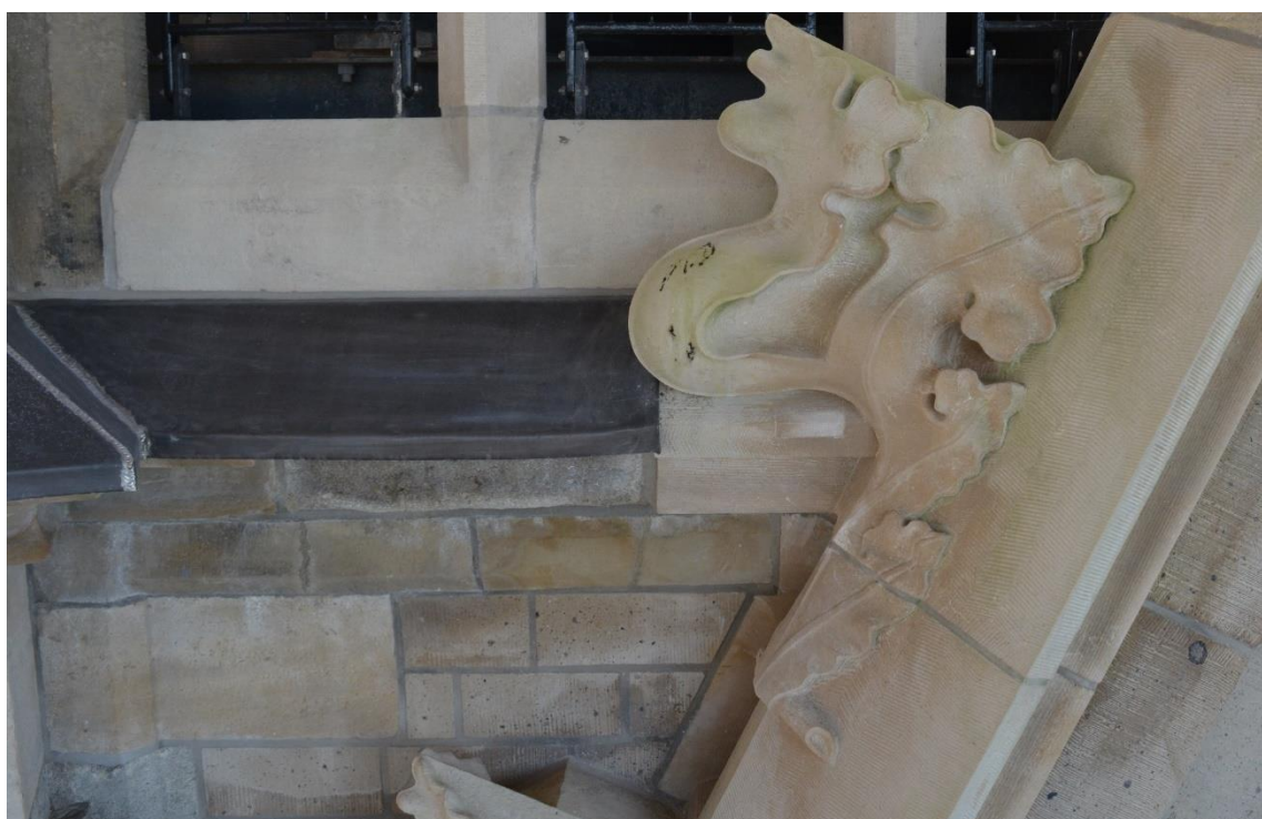
Foto 47 – voorbeeld van loodafdekkingen van waterlijsten
