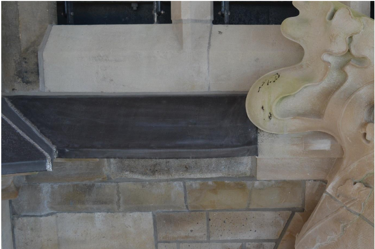
Afb. Kwetsbare en historisch waardevolle maar waterbelaste onderdelen voorzien van loden afdekking om in de toekomst zo veel mogelijk te beschermen tegen verder verval.
