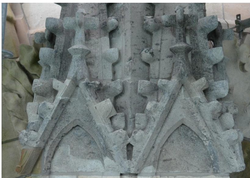
Afb. een voorbeeld van inschietwerken in een bestaand blok natuursteen. De natuursteenkeuze voor inschietblokjes dient esthetisch en technisch bij het originele blok te passen. Inschietingen worden nagenoeg onzichtbaar verlijmd met het oorspronkelijke blok (geen zichtbare voegen).
