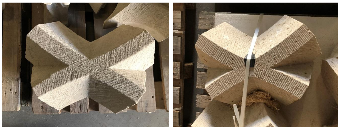
Afb. Twee voorbeelden van natuursteen afwerking op hetzelfde blok, links het originele (terug te plaatsen blok) met historische afwerking en rechts een nieuw blok met de historische afwerking daarop geïmiteerd.
