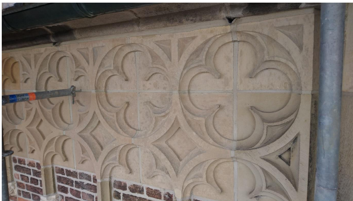
Afb. Voorbeeld van restauratie voegwerk wat platvol (iets verdiept) is aangebracht en in kleur afgestemd op omliggende natuur- en baksteenwerk.
